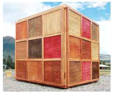
Proyecto "El Cubo de Totora" del estudio Archcube think-act tank. El tejido de junco y totora adquiere protagonismo y forma parte de la fachada.
