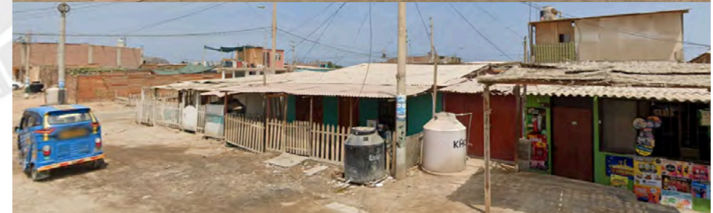
Afloración de agua en AA. HH Defensores de la Patria Fuente Google Maps
