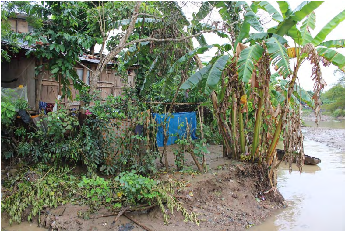
Figura 6: Terreno erosionado en la desembocadura de la quebrada Chambira, zona de Juanjuicillo
