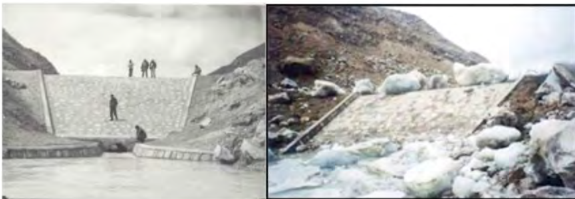
Figura 1.5: Obras civiles implementadas en la laguna Palcacocha. Fuente: Registro fotográfico del Ing. Cesar Portocarrero y de la Unidad de Glaciología.
