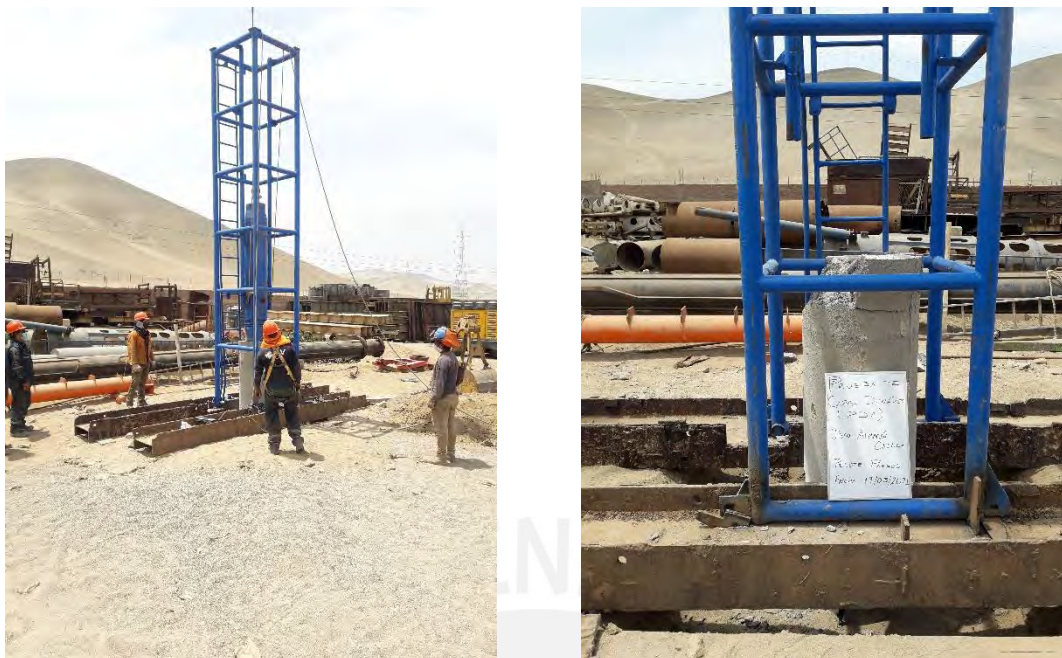
Figura 10. Ejecución de ensayo dinámico PDA en Chilca, Lima.
