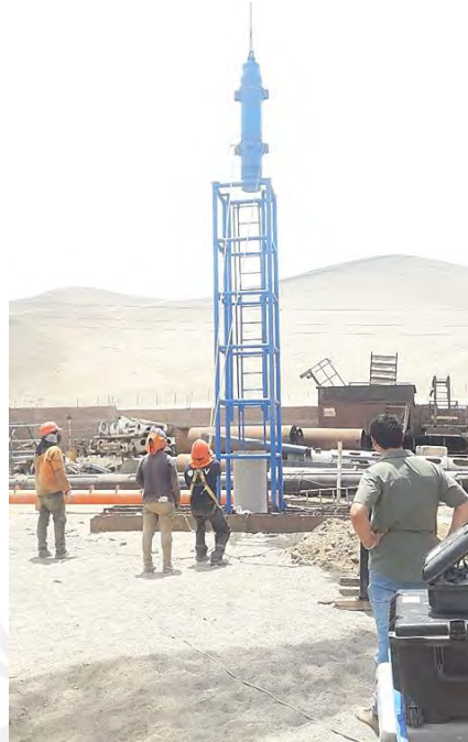
Figura 16. Supervisión de la correcta ejecución de la prueba de carga dinámica.
