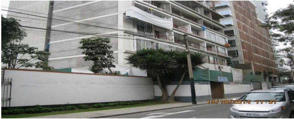
Figura 22: Vista lateral del edificio Clement
