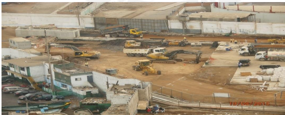
Figura 34: Disposición de RCD en el Terminal muelle norte del Callao
