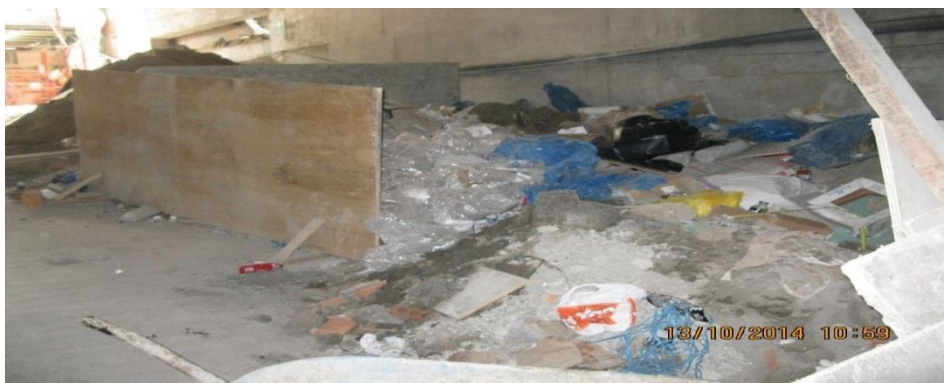
Figura 28: Disposición de RCD del edificio Clement
