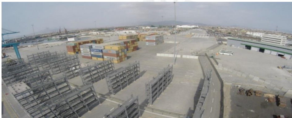
Figura 24: Vista aérea del Terminal muelle norte del Callao
