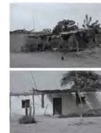
[2] VIVIENDAS EN ESTADO MEDIO RAMADA, ALGARROBO, ADOBE
