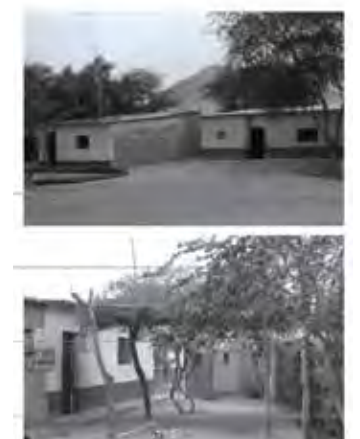
[3] VIVIENDAS EN BUEN ESTADO LADRILLO
