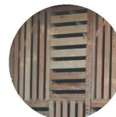
Celosías de madera
