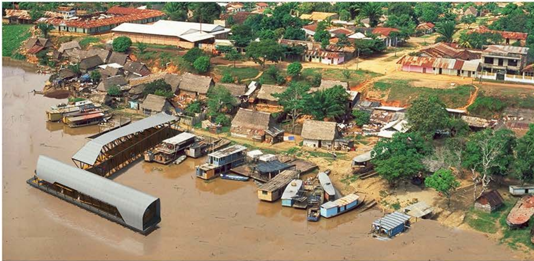
VISTA AEREA EMBARCADERO_MATROCASA
