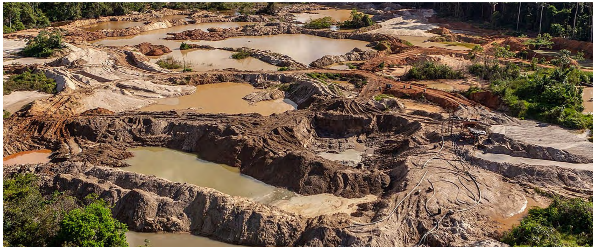
Fotografía 22: Charcos de agua estancada y contaminada generado por la minería en Venezuela. Fuente: Carmelo Urso, 2016.
