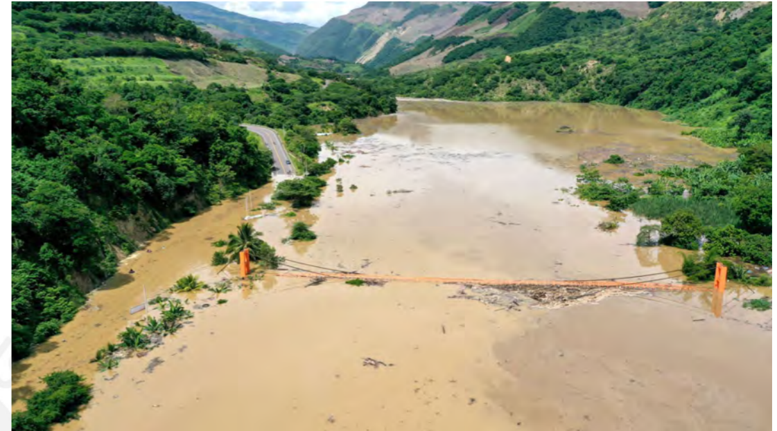
Fotografía 46: Puerto Naranjitos tras el desborde del río Utcubamba. Fuente: Andina, 2021.
