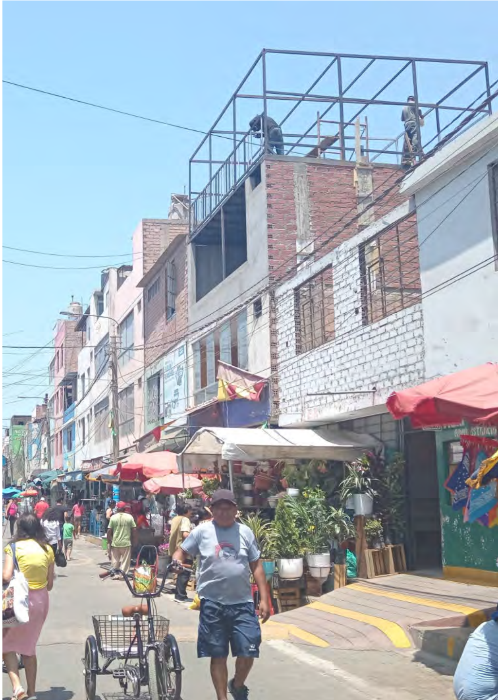
Fuente: Propia 2023, construcción de edificios con acero
