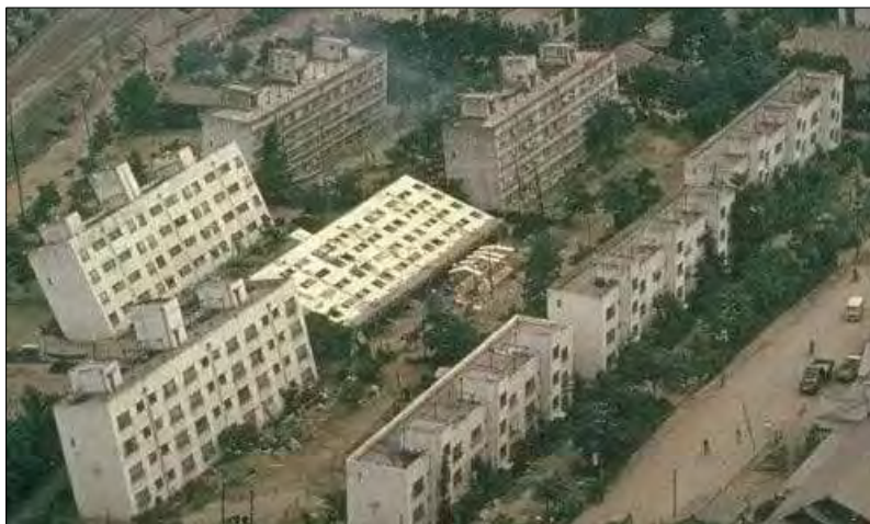
Figura 1.1: Licuefacción de suelos a causa del terremoto en Niigata (1964). Fuente web: https://www.sol-solution.com/es/article/prevencion-de-los-fenomenos-de-licuefaccion/
