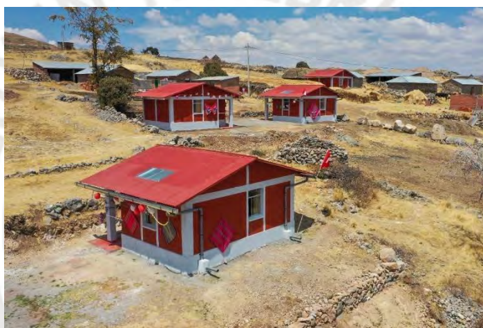
Imagen 1: Módulos habitacionales Sumaq Wasi
