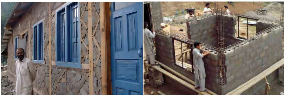
Figura 7. Izq. Reforzamiento estructural de viviendas Der. Construcción hasta el nivel del dintel
