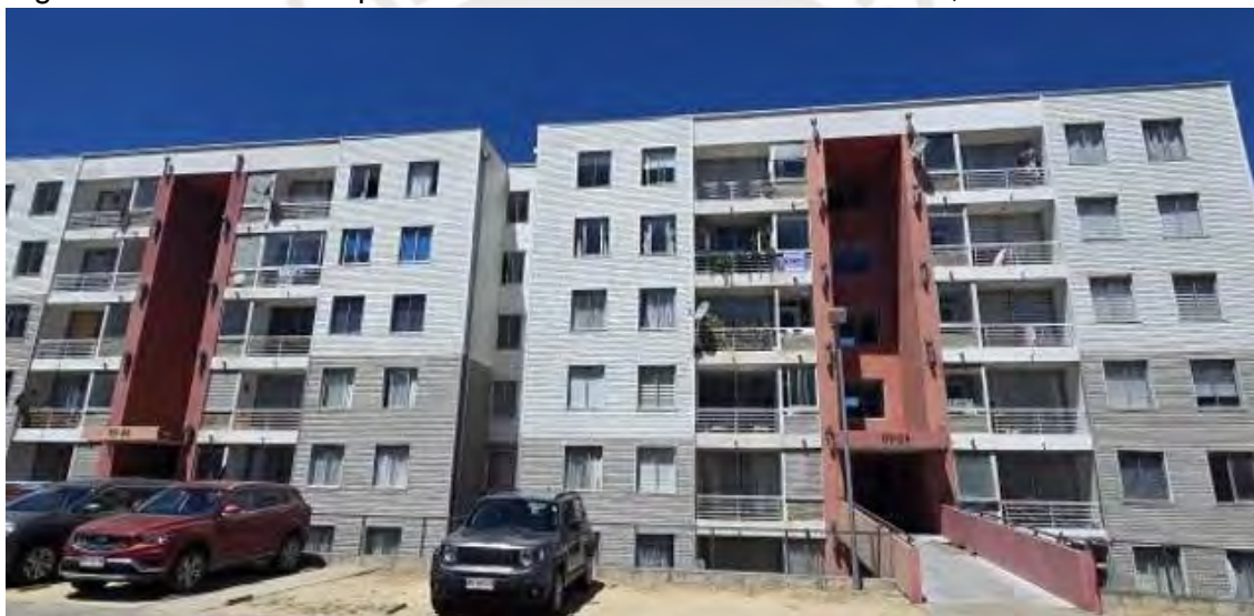
Figura 22. Edificio de departamentos en condominio Bicentenario, Constitución
