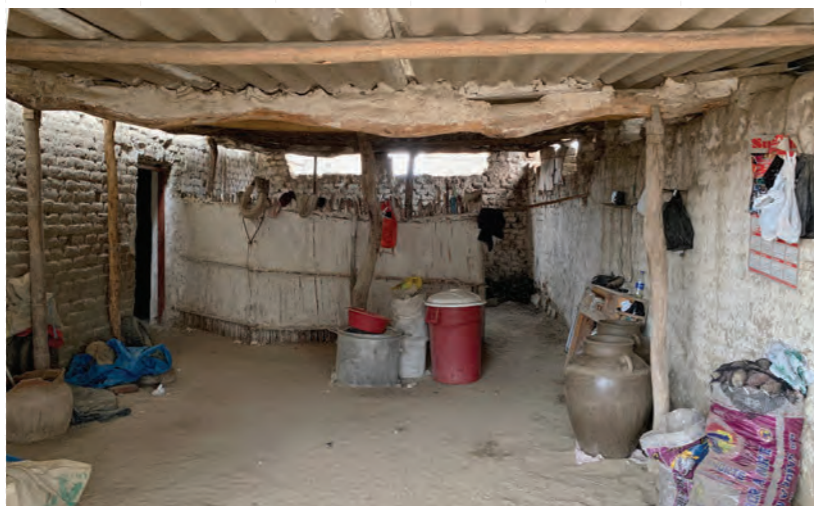
adobitos, madera rollizo, troncos irregulares
