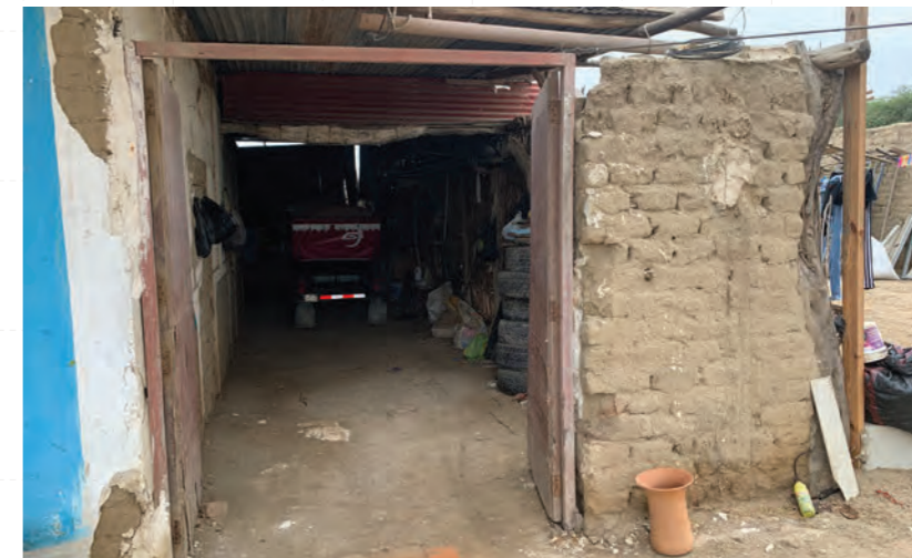
Depósito en la entrada
