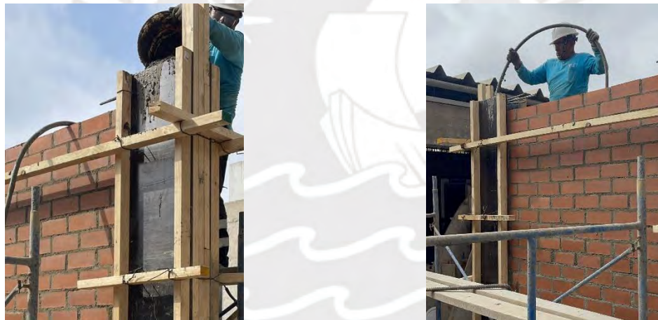
a) Vaciado de concreto y vibrado en las columnas
