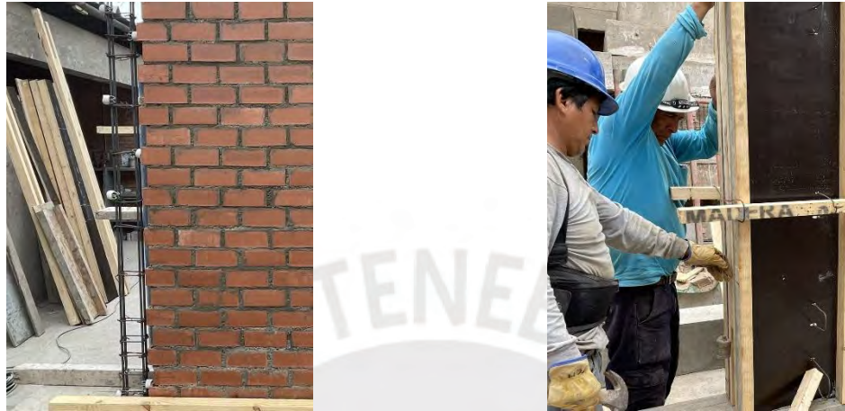
a) Verificación de recubrimiento y encofrado de las columnas
