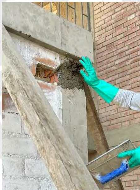
Figura 7.5: Reemplazo de concreto deteriorado en la columna
