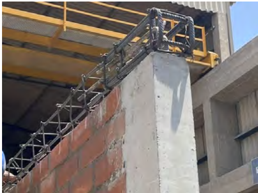
a) Habilitación de acero y encofrado de la viga solera
