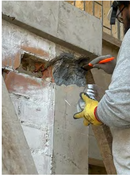
Figura 7.4: Aplicación de resina epóxica en las superficies intervenidas
