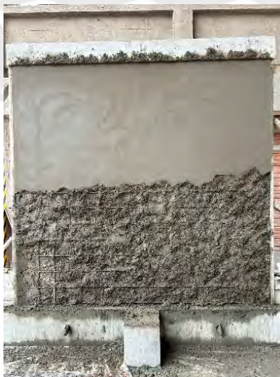
Figura 7.16: Pañeteo y tarrajeo del muro
