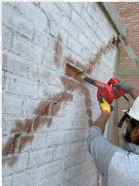
Figura 7.3: Limpieza de fisuras y eliminación de residuos con soplador de aire
