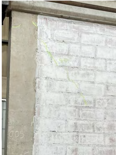
Figura 9.11: Primera falla por corte en el muro M1-CA
