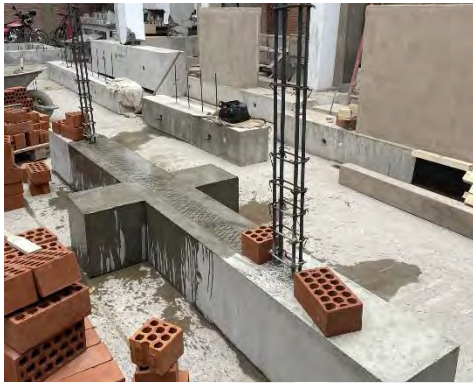
a) Humedecimiento de la viga de cimentación y asentado de la primera hilada.
