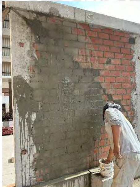
Figura 7.7: Aplicación de lechada sobre el muro de albañilería
