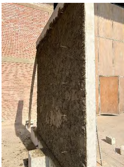
Figura 7.12: Colocación de conectores de alambre
