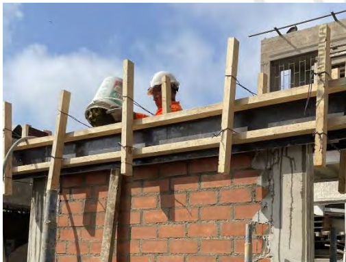
b) Vaciado de concreto de la viga solera y curado de elementos de confinamiento
