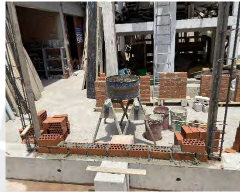
a) Humedecimiento de la viga de cimentación y asentado de la primera hilada.
