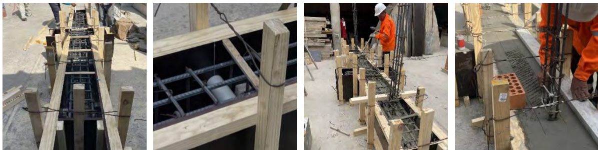
Figura 5.4: Procedimiento constructivo de la viga de cimentación
