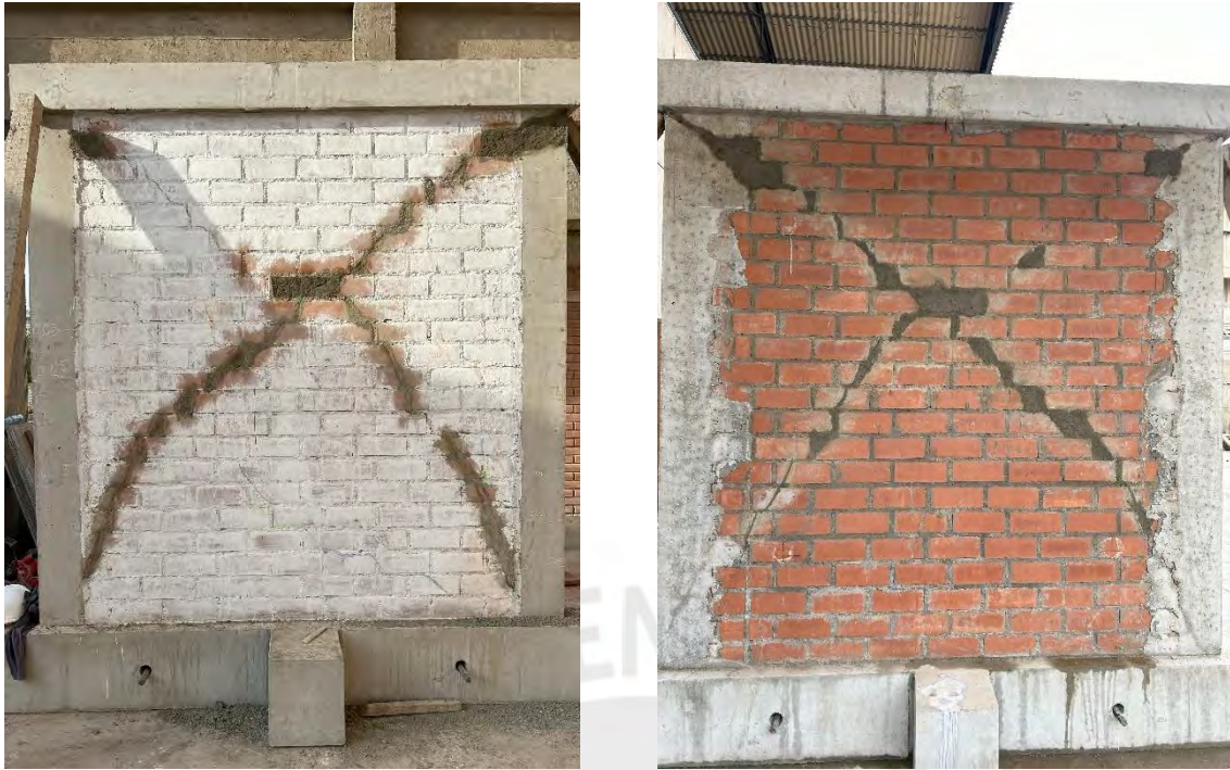
Figura 7.6: (Izquierda) Cara frontal y (derecha) cara posterior del muro M1-CA después de la reparación
