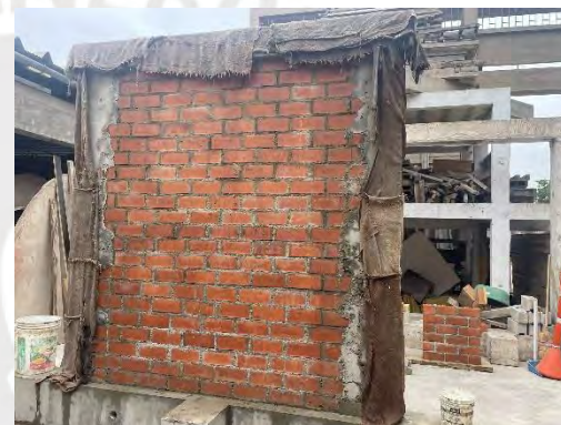
b) Vaciado de concreto de la viga solera y curado de elementos de confinamiento
