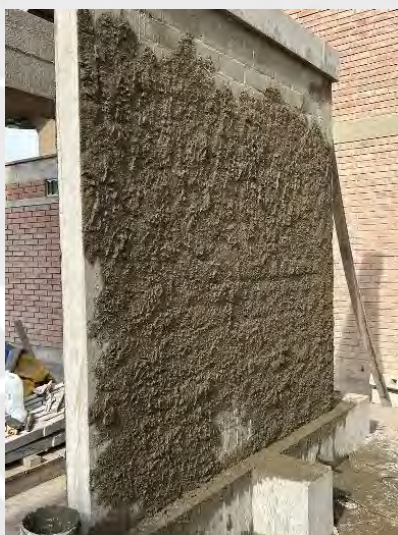
Figura 7.13: Aplicación de mortero para el pañeteo del muro en la cara frontal
