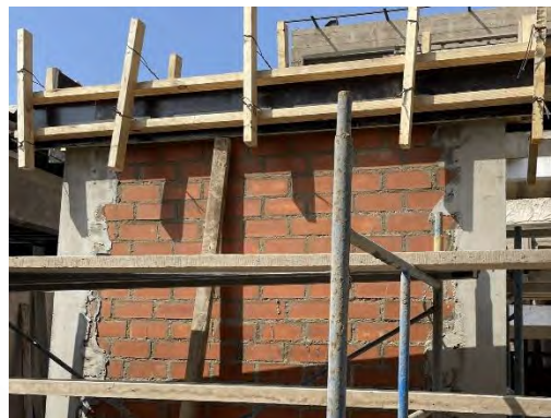
a) Habilitación de acero y encofrado de la viga solera
