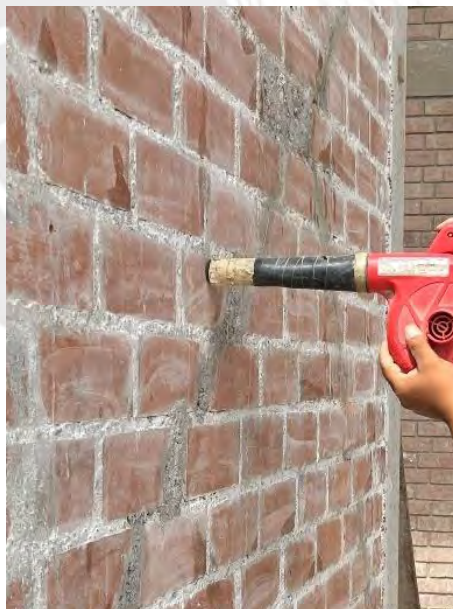
Figura 7.11: Limpieza de perforaciones en muro de albañilería con soplador de aire
