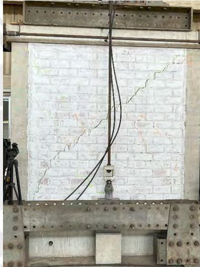
Figura 9.12: Falla por corte en el M1-CA (fase 6)
