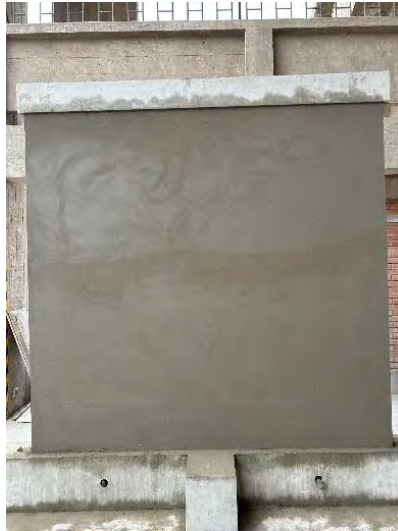
Figura 7.17: Acabado final del muro con tarrajeo
