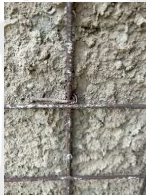
Figura 7.15: Detalle de la fijación de los conectores para las mallas electrosoldadas mediante atortolado de alambre
