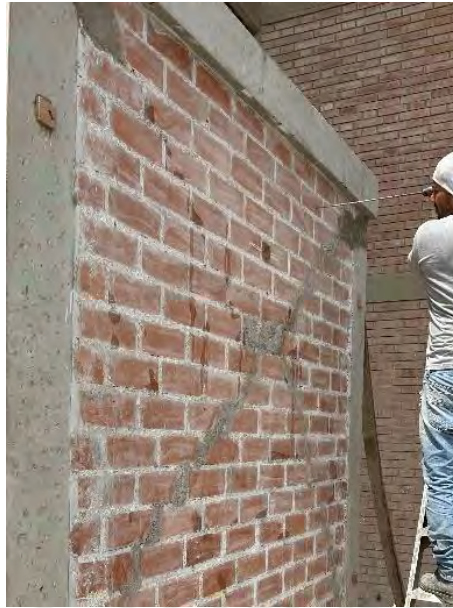
Figura 7.10: Perforación en el muro de albañilería para colocar el refuerzo estructural
