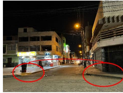
Figura 5: Falta de continuidad de rampa (Rímac-Chira) Fuente: Elaboración propia
