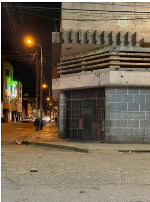
Figura 3: Improvisación de rampa (Rímac-Chira) Fuente: Elaboración propia
