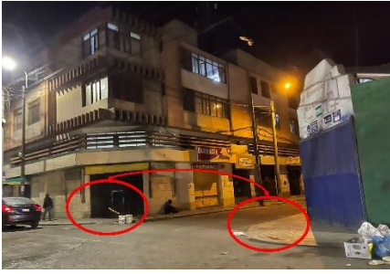
Figura 1: Falta de continuidad rampa (Rímac-Aguatía) Fuente: Elaboración propia
