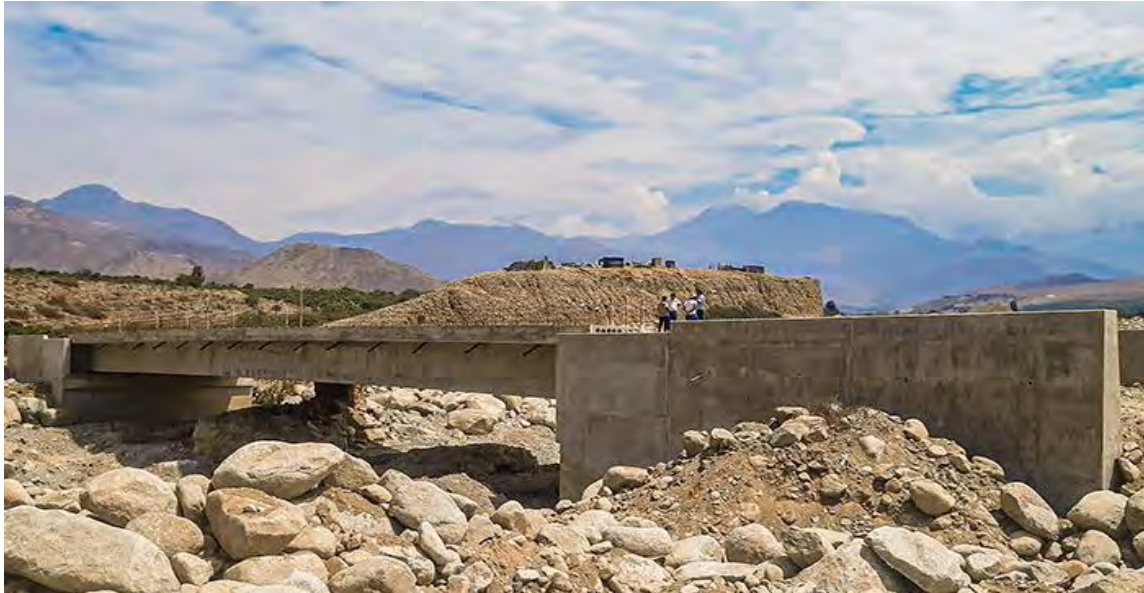
Puente de Huanchuy
