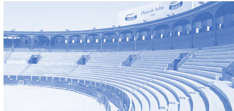
Imagen 16. Vista de la infraestructura de graderías interiores. Fuente: Elaboración propia
