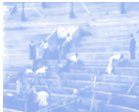
Imagen 13. Obreros en el proyecto de ampliación de la Plaza de Acho Fuente: BNP. (1944). La Plaza de Acho se remozó [Video] . Biblioteca Digital BNP
