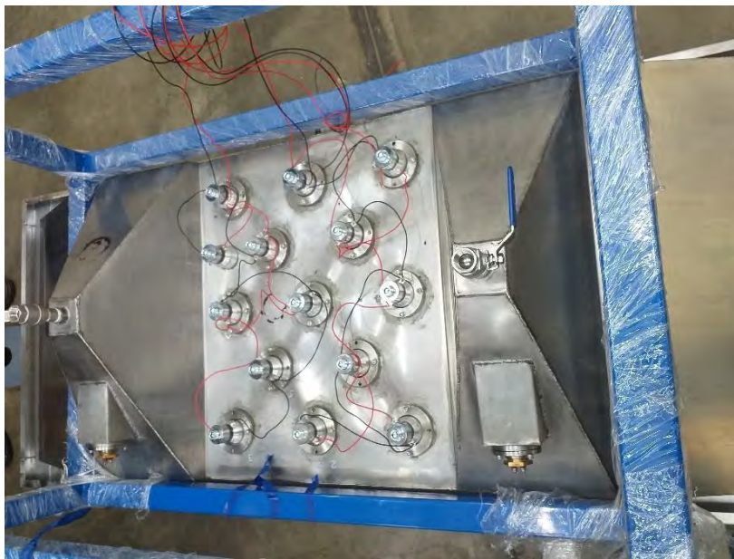
Figura 32. Instalación eléctrica de los actuadores de ultrasonido
