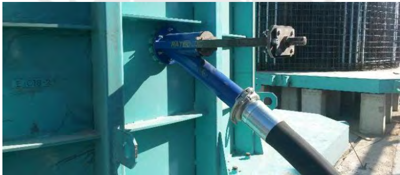
Imagen 54: Conexión de pompe UCI Basic Fuente: Ratec Org
