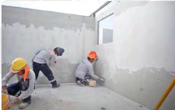
Imagen 82: Empaste de muros de concreto
