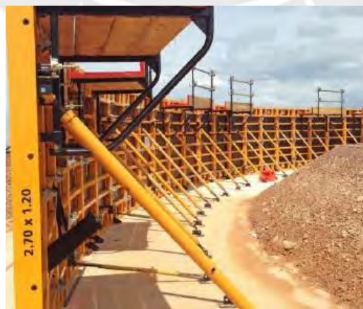
Imagen 3: Encofrado de caras de Muro curvo
