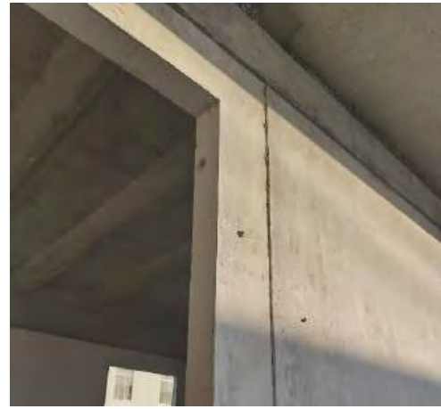
Fotografía 10: Casa Buenavista – Vano puerta Fuente: Propia
