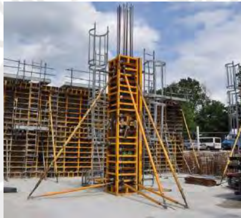
Imagen 2: Encofrado de caras de Columna cuadrada
