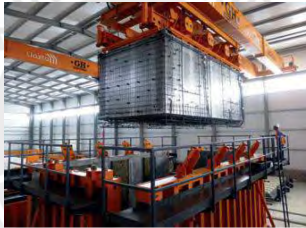
Imagen 59: Preparado del núcleo con armadura de acero de refuerzo
