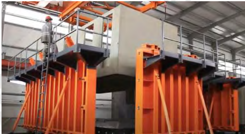
Imagen 79: Izado de la estructura modular luego de desencofrar
