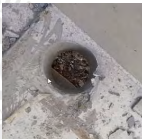
Fotografía 23: Orificio para colocación de tuerca de anclaje Fuente: Propia
