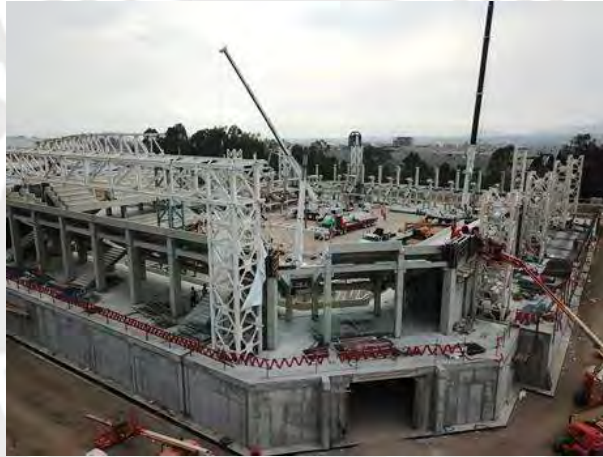
Imagen 24: Estructuras metálicas prefabricadas – Complejo de Villa el Salvador
