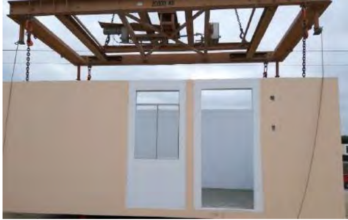
Imagen 83: Pintado de muros e instalación de puertas y ventanas
