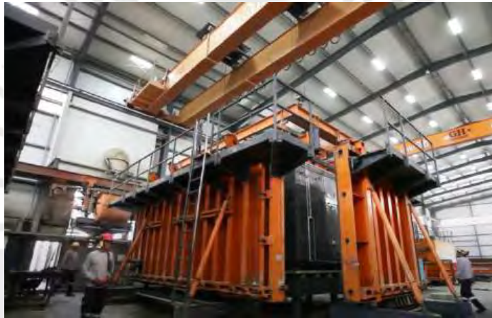
Imagen 75: Encofrado modular antes de cerrar la estructura metálica
