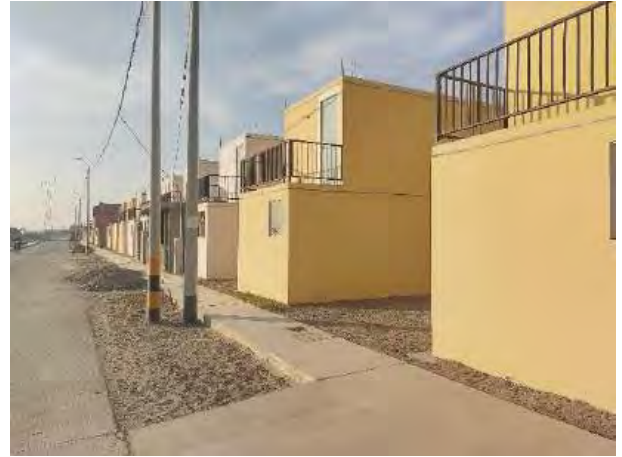
Fotografía 16: Urb. Buenavista – Casa Gardenia (1) Fuente: Propia
