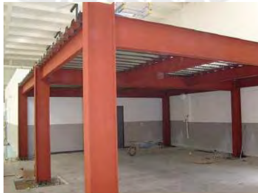
Imagen 31: Vigas y columnas de acero
