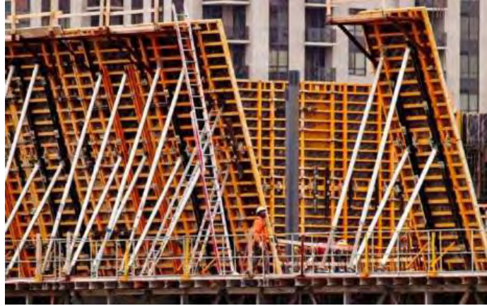
Imagen 1: Encofrado de caras de Muro
