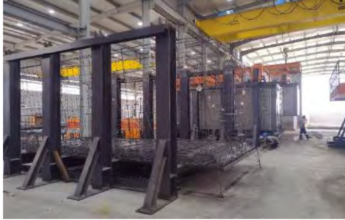
Imagen 68: Armado de acero de refuerzo
