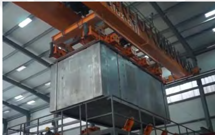
Imagen 77: Desencofrado de estructura – retirada de núcleo retractil
