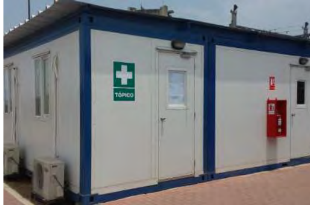
Imagen 35: Sistema acero galvanizado - Oficina de campo – Metro de Lima (2016)
