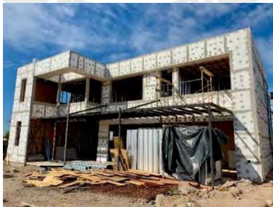
Imagen 19: Revestimiento de estructura metálica con paneles de concreto y yeso
