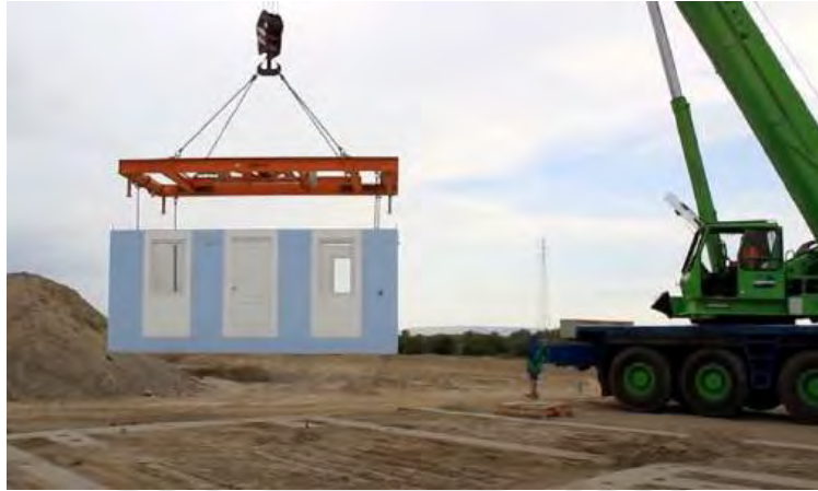
Imagen 85: Izado de módulo de concreto armado Fuente: Reymann Technik & Ratec Org
