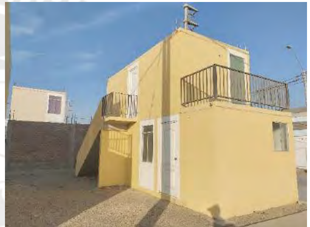
Fotografía 17: Urb. Buenavista – Casa Gardenia (2) Fuente: Propia
