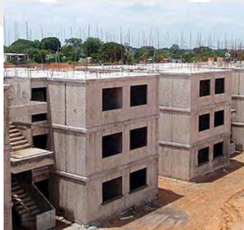
Imagen 15: Edificación construida con paneles de encofrado de aluminio
