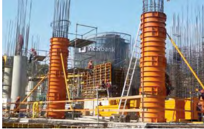
Imagen 4: Encofrado de caras de Columna circular
