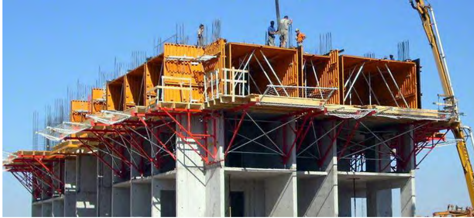
Imagen 17: Armado y bombeo monolítico de muros y losas
