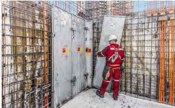
Imagen 99: Paneles principales de muros
