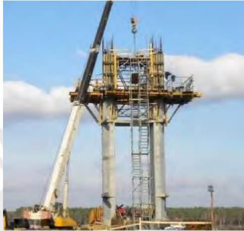
Imagen 7: Encofrado trepante (desplazamiento con grúa)
