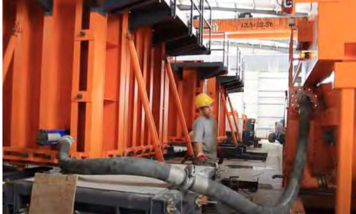
Imagen 76: Vaciado de concreto mediante inyección a presión
