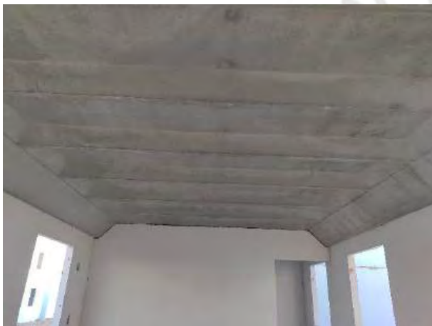
Fotografía 8: Casa Buenavista – Losa nervada (1) Fuente: Propia
