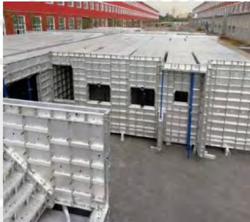
Imagen 14: Paneles de encofrado de aluminio
