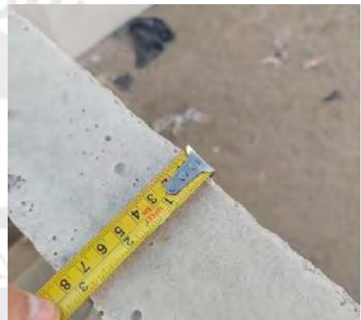
Fotografía 11: Casa Buenavista – Espesor de muros (1) Fuente: Propia
