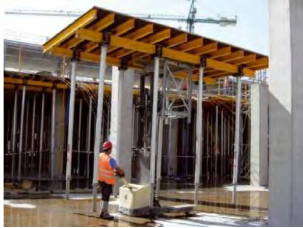
Imagen 6: Encofrado tipo mesa para Losas (2)
