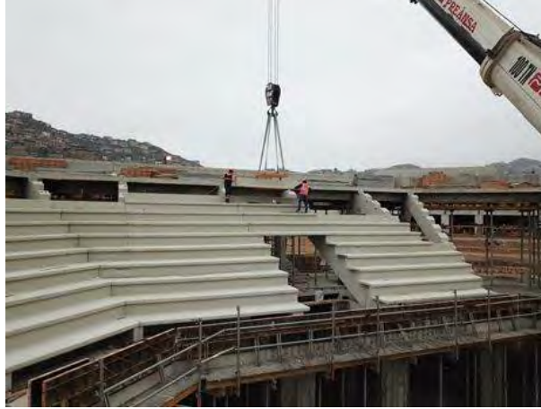
Imagen 23: Gradas prefabricadas de concreto armado – Complejo de Villa María
