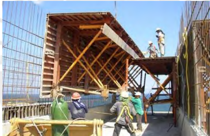
Imagen 16: Colocación de la estructura de encofrado en “L” invertida
