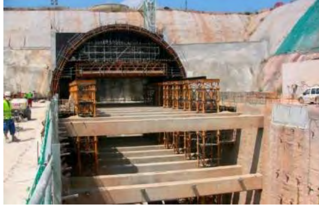
Imagen 12: Encofrado de túnel en tajo abierto
