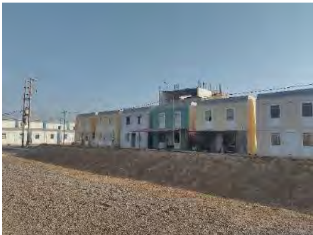
Fotografía 19: Urb. Buenavista – Casa Acacia Fuente: Propia
