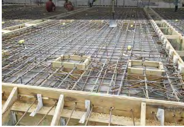
Imagen 20: Encofrado horizontal y armado de acero de refuerzo
