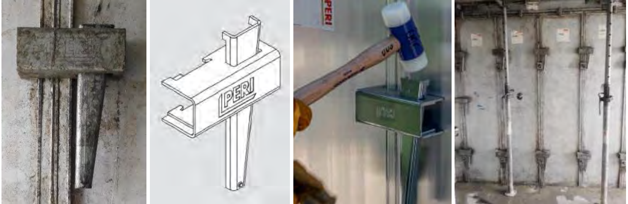
Imagen 103: Cerrojo de paneles de muros)
