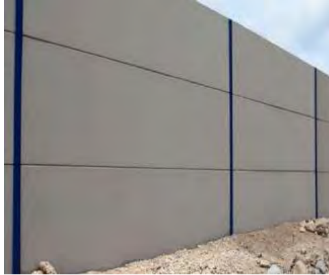
Imagen 29: Placas de concreto para cerco perimétrico
