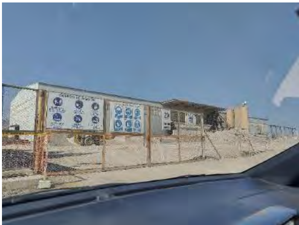
Fotografía 1: Vista externa – Planta de producción Ica Fuente: Propia
