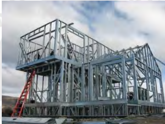
Imagen 18: Estructura de acero galvanizado liviano
