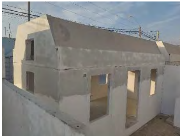
Fotografía 22: Vista cubierta de vivienda Fuente: Propia
