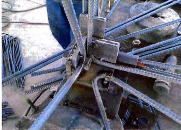
Imagen 90: Detalle en obra de placa unión entre módulos
