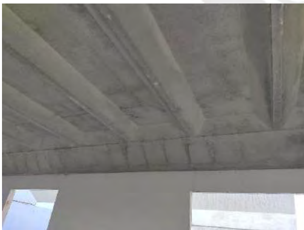
Fotografía 9: Casa Buenavista – Losa nervada (2) Fuente: Propia
