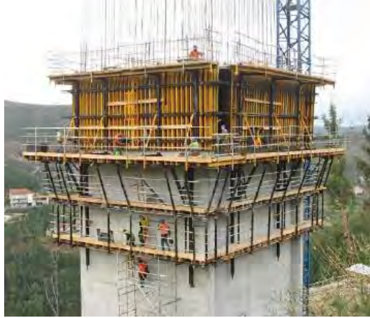
Imagen 9: Encofrado autotrepante (mecanismo hidráulico y mecánico)
