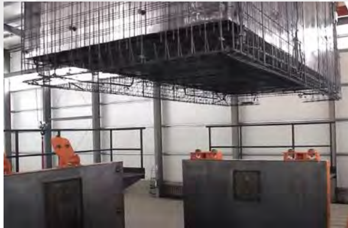
Imagen 73: Izado y traslado de conjunto modular interno (núcleo + estructura metálica)
