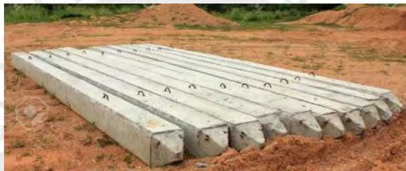
Imagen 30: Pilotes prefabricados de concreto
