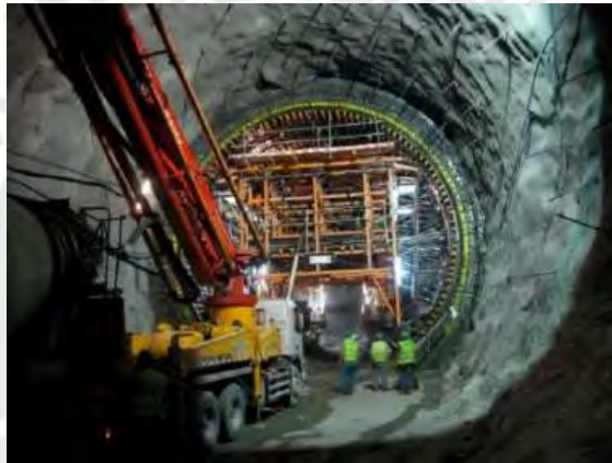
Imagen 13: Encofrado de túnel al interior de mina
