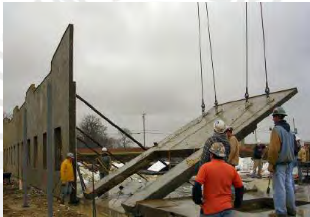
Imagen 21: Izaje de paneles de concreto mediante insertos y grua
