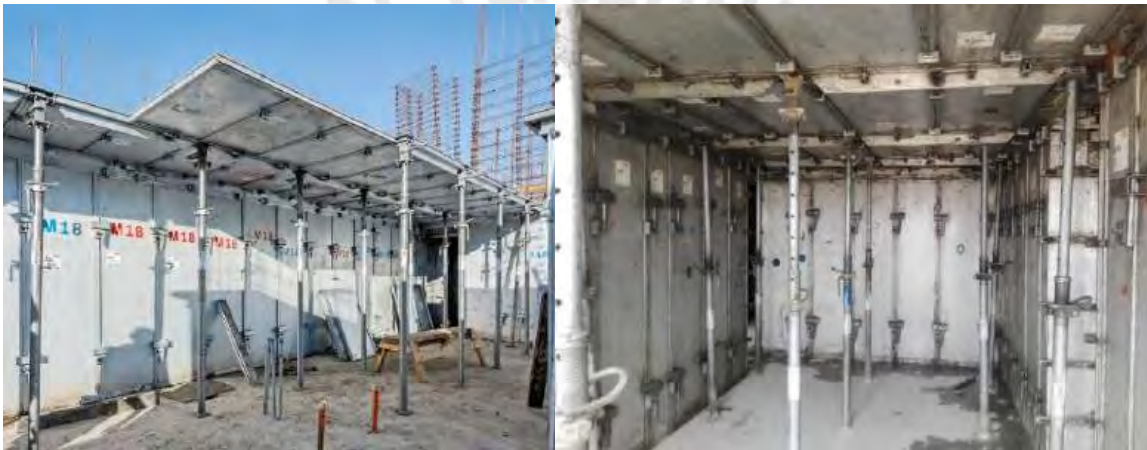
Imagen 104: Paneles de cierre de losa y Puntales de Losas de Encofrado
