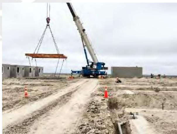
Fotografía 24: Izaje y colocación de vivienda - Piura Fuente: Propia
