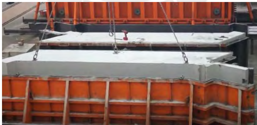
Imagen 80: Izado de balcones luego de desencofrar
