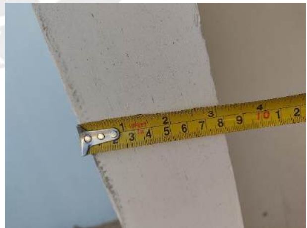
Fotografía 12: Casa Buenavista – Espesor de muros (2) Fuente: Propia
