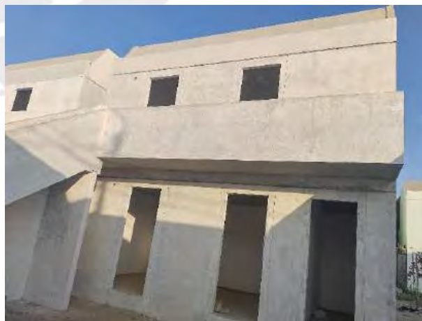
Fotografía 6: Casa Buenavista – casco fachada interior Fuente: Propia
