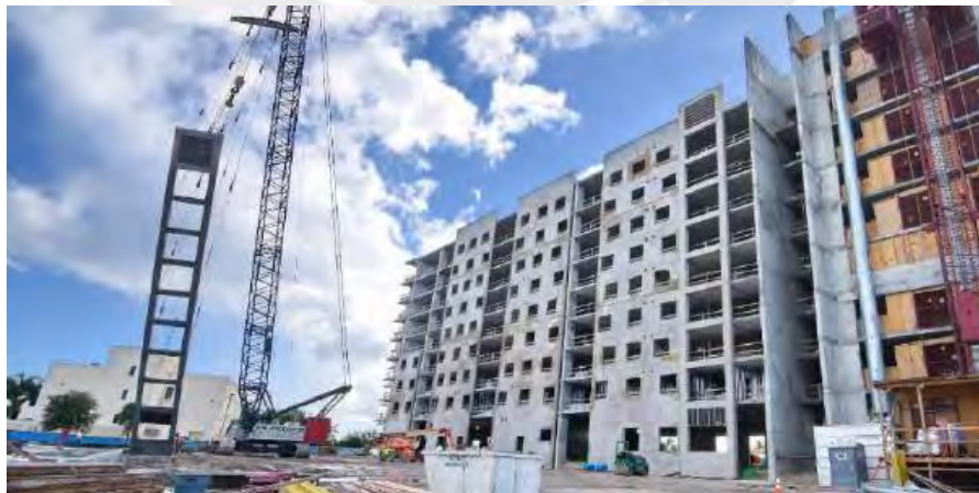
Imagen 22: Construcción compleja Biscayne Bay, Miami
