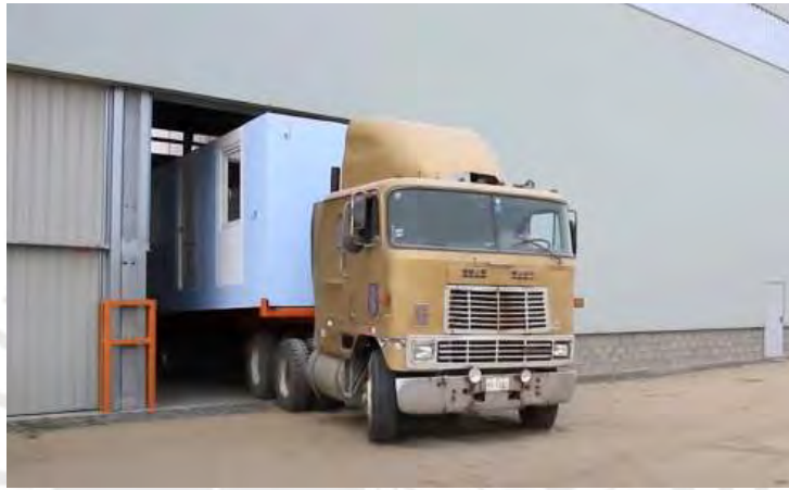
Imagen 84: Traslado de módulo de vivienda
