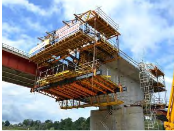
Imagen 11: Encofrado de puente con carro de avance
