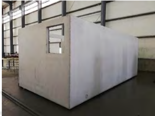
Imagen 81: Posicionamiento de módulo post izaje
