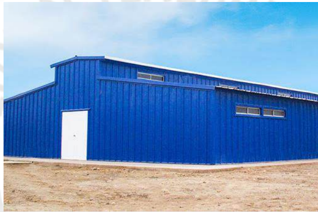
Imagen 36: Hospital de Contingencia de Pisco
