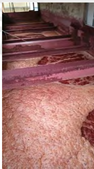
Figura 15. Planta de tratamiento de aguas residuales
