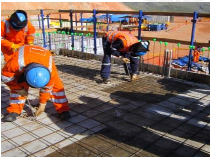
39. Colocación del acero de refuerzo de losas.
