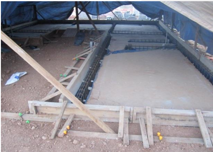
17. Colocación de armadura de acero para las vigas de cimentación.
