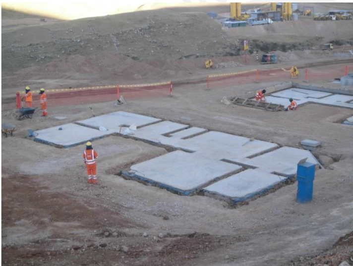
14. Vista final de solado con las zanjas excavadas.
