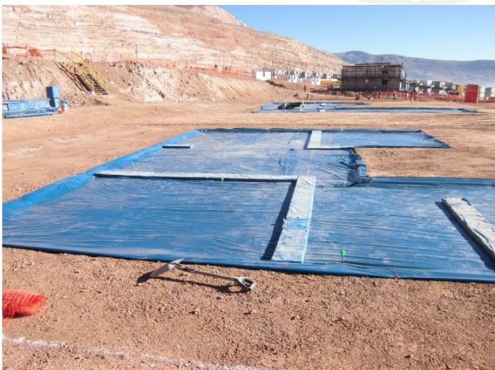
09. Colocación de niveles y planchas de poliestireno expandido forradas con plástico en zonas de vigas de cimentación. Este material permite realizar el posterior trabajo de excavación de forma más sencilla.
