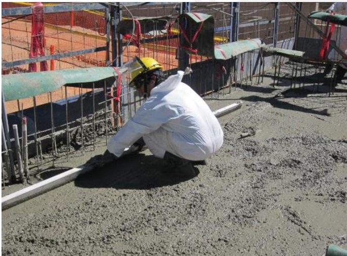
44. Acabado de la superficie de concreto.
