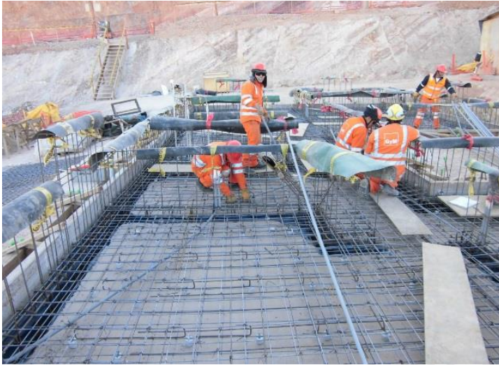
19. Instalaciones eléctricas y sanitarias de platea
