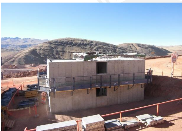
53. Vivienda con el segundo nivel terminado. Se cuentan con las mechas para iniciar la construcción del tercer y último nivel.
