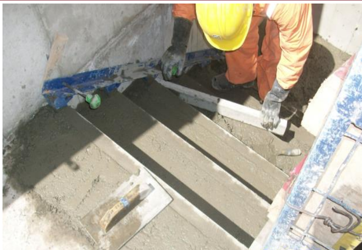
61. Acabado de concreto premezclado.
