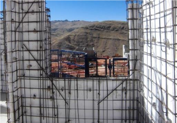
31. Colocación de acero de refuerzo especial. En este caso su muestra el caso de vanos.
