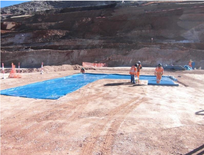
08. Colocación de plástico para evitar el contacto directo suelo – concreto.
