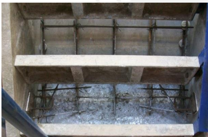
59. Aplicación de pegamento epóxico en el arranque y entrega de escalera.
