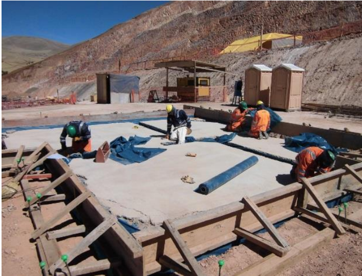
16. Colocación de plástico en zanjas para evitar el contacto directo suelo – concreto.
