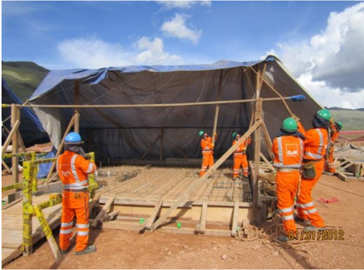
20. Instalación de carpa para protección del concreto de la platea de las condiciones climáticas.
