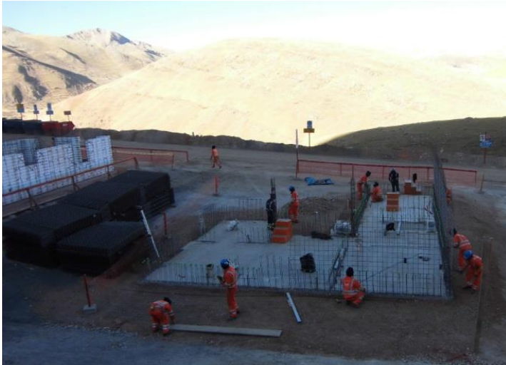
28. Colocación de mallas electrosoldadas y de refuerzo de acero de muros.
