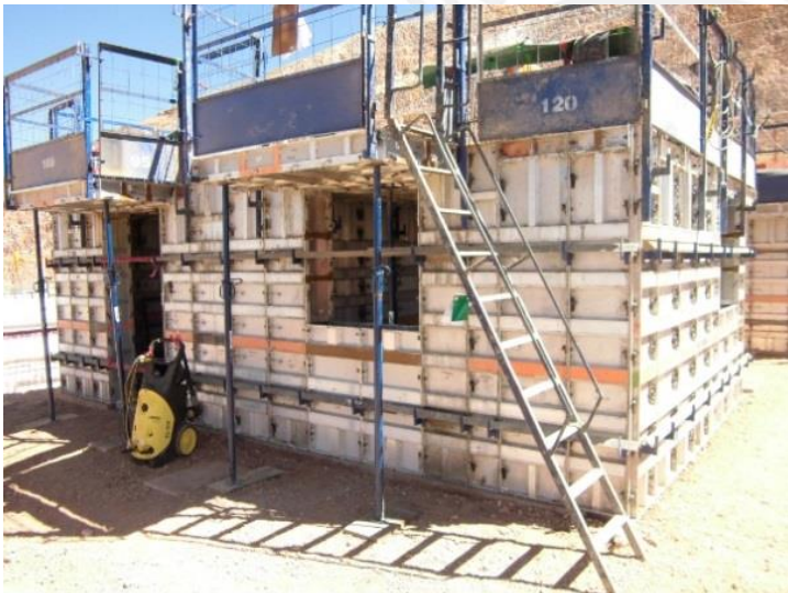
38. Vista del encofrado de una vivienda tipo 1R. El encofrado incluye la instalación de guardacuerpos, pasarelas o andamios.
