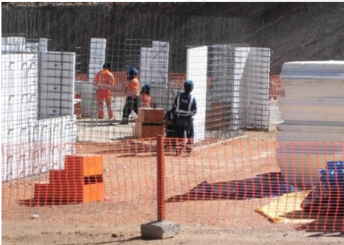
29. Colocación de planchas de poliestireno para muros perimetrales.
