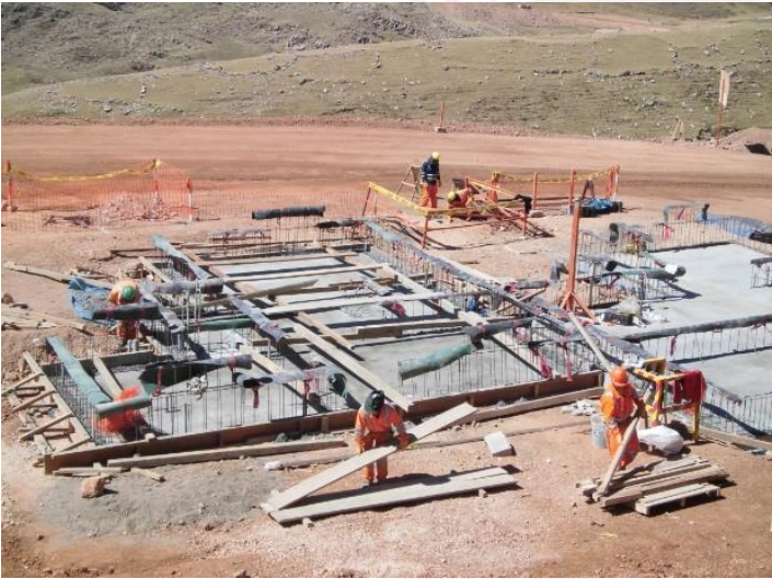
26. Desencofrado de platea de cimentación.
