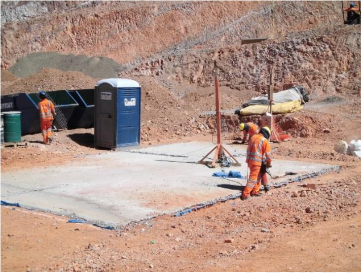
13. Excavación de zanjas para vigas de cimentación y desagüe.
