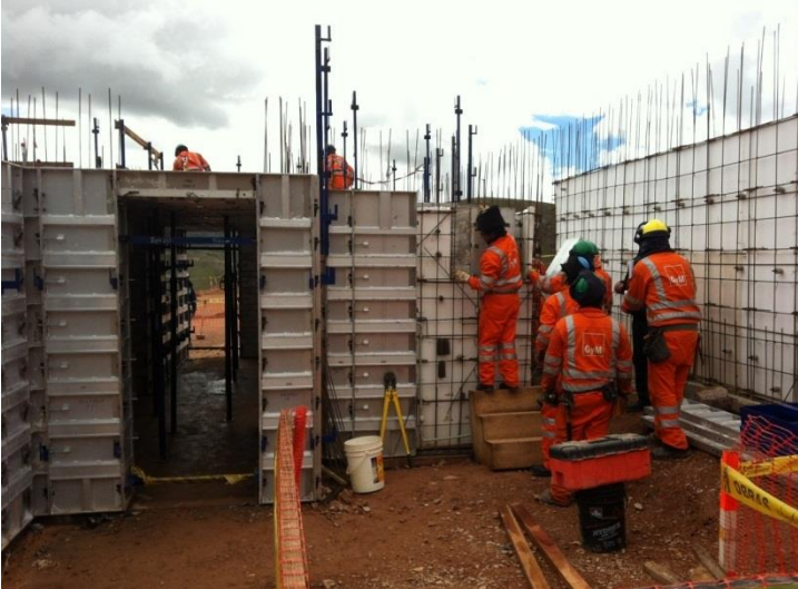
35. Encofrado metálico para muro.
