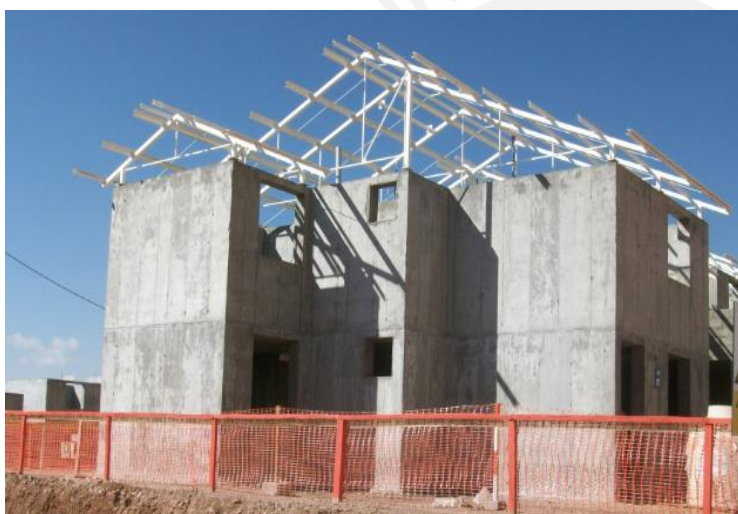
62. Vivienda de dos niveles con la estructura metálica del techo del último nivel ya instalada.
