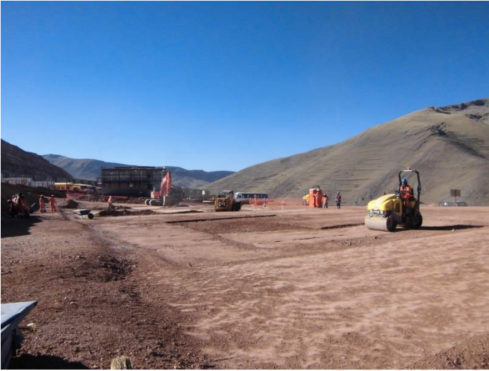
07. Nivelación y compactación de excavación.
