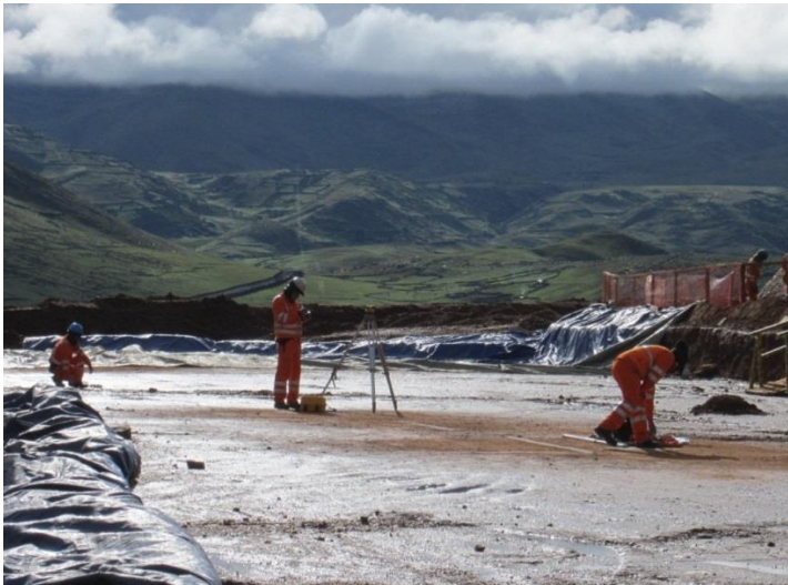
04. Trabajos de topografía para el trazo y replanteo de la poligonal de la vivienda y de sus muros perimetrales e interiores.
