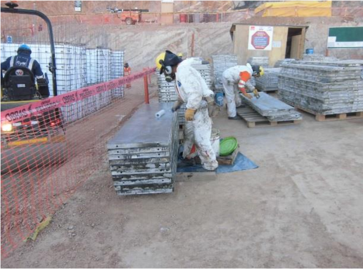
34. Habilitación del encofrado. Limpieza con espátula y aplicación de desmoldante.
