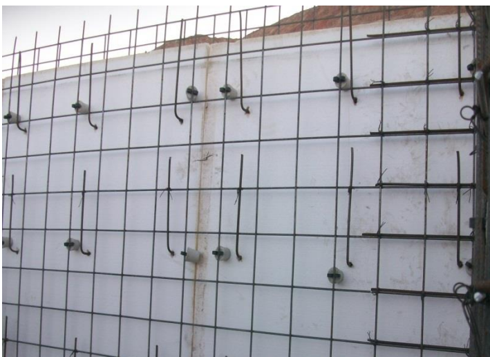
30. Colocación de separadores de acero y de concreto pobre, y del acero de sostenimiento.
