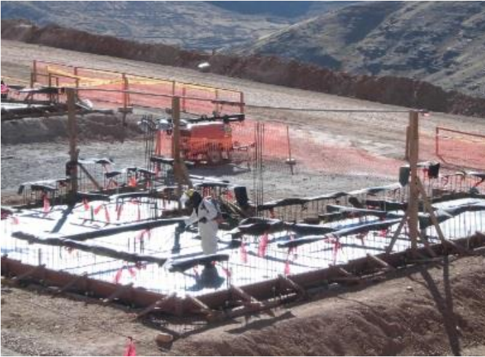
25. Curado de la platea de concreto.
