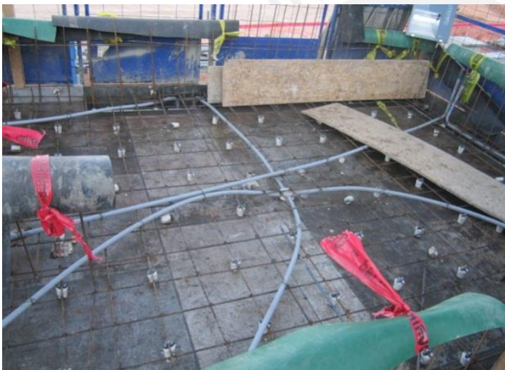
41. Instalaciones eléctricas de losa.
