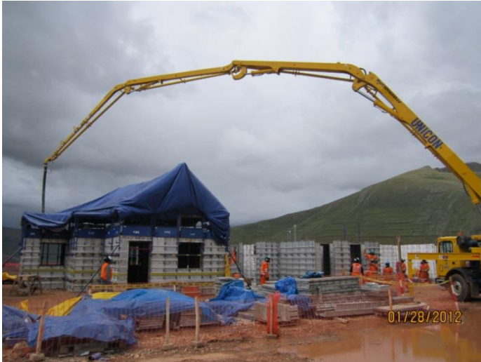
43. Vaciado monolítico muro – losa. En este caso el vaciado se está realizando con la carpa cubriendo totalmente la vivienda debido a que el clima anticipa lluvias.
