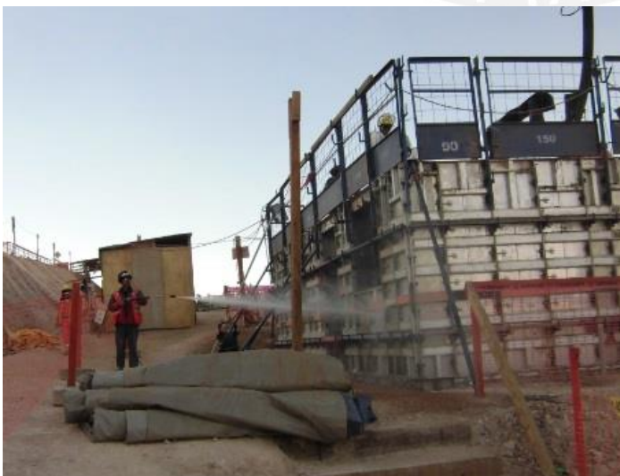
45. Limpieza de encofrado con hidrolavadora cuando el vaciado está por terminar.
