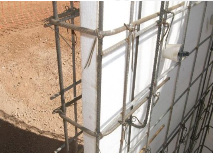
32. Colocación de suples para la unión de las mallas electrosoldadas interiores y exteriores de los muros perimetrales.
