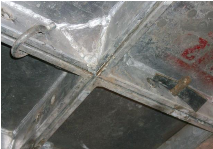
37. Paneles de losa asegurados mediante pinos grapa y pasadores cortos ajustados con cuñas.
