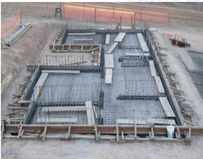
18. Colocación y empalme de mallas electrosoldadas, bastones y dowels para muros.
