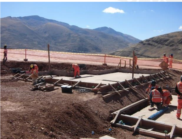
15. Encofrado de borde de platea de cimentación.
