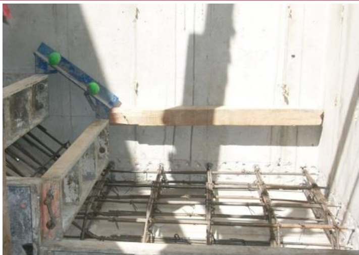
58. Encofrado y acero de la escalera.
