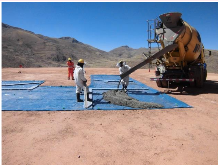
10. Vaciado de concreto para solado.
