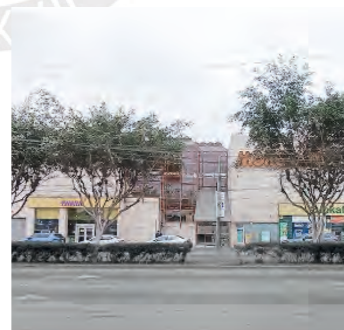
Figura 31: Fotografías del Centro Comercial Molicentro (2025) Fuente: Elaboración propia
