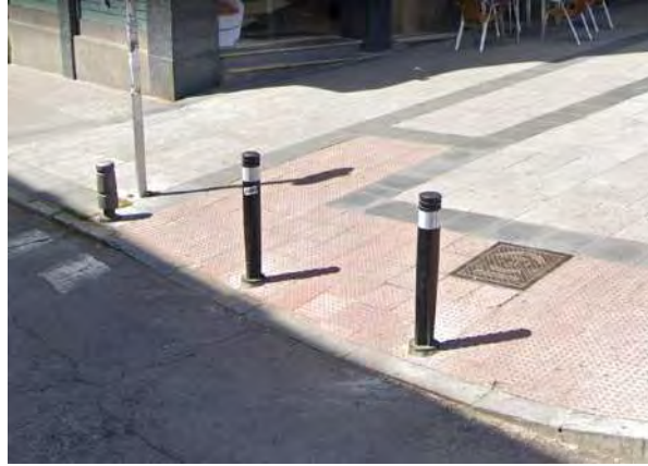
Figura 40. Bolardos modelo caucho en cruce de la calle de Antillón con el Paseo de Extremadura
