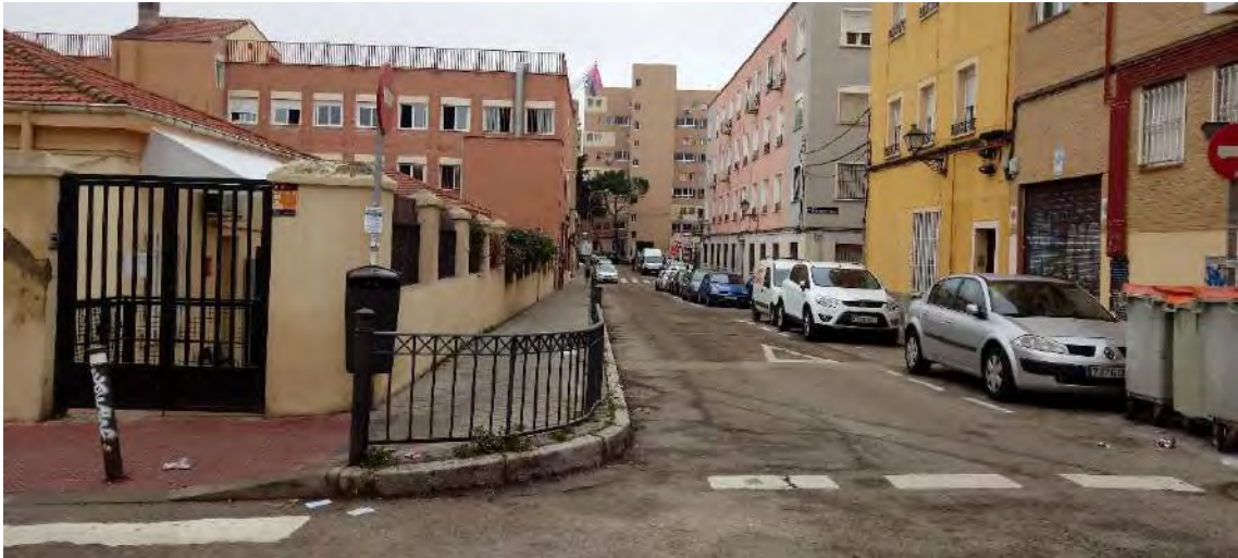
Figura 50. Barandillas de la Escuela Infantil de Puerta del Ángel en la calle de Antillón
