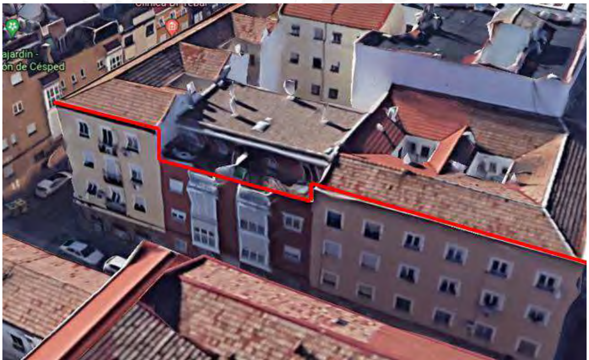
Figura 38. Fachadas de distintas alturas en la mazana de Antillón 16 a Antillón 20
