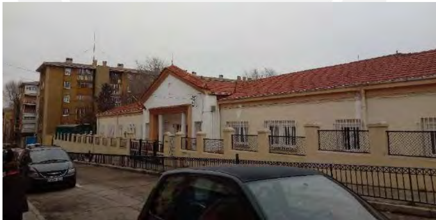
Figura 49. Barandillas de la Escuela Infantil de Puerta del Ángel en la calle de Juan Tornero
