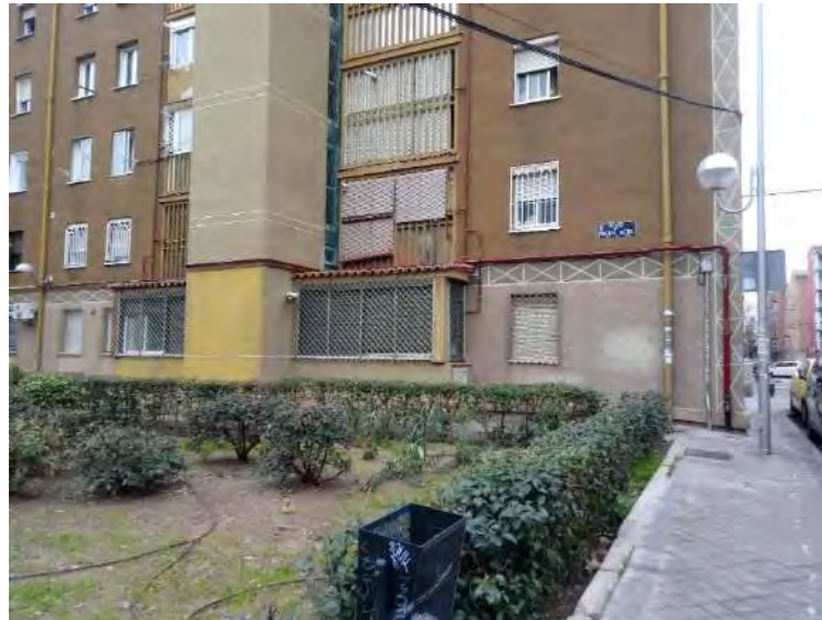
Figura 20. Cruce de la Plaza Puente de Genil con la calle de Antillón
