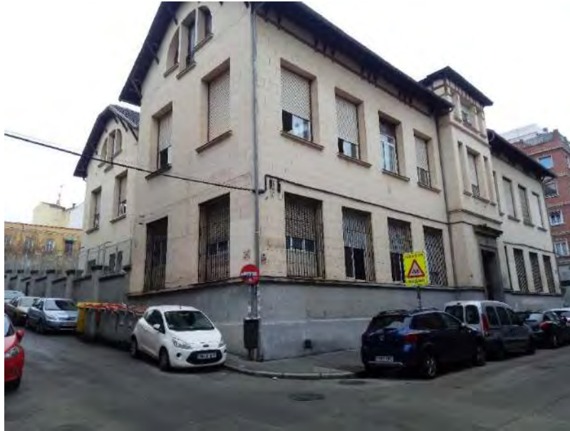
Figura 12. Colegio María Cristina (frente ubicado en la calle de Antillón)
