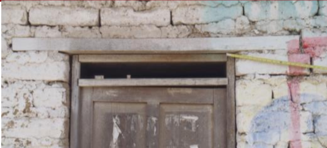
Fig.15 Vano de puertas con dintel, vivienda en Apan.
