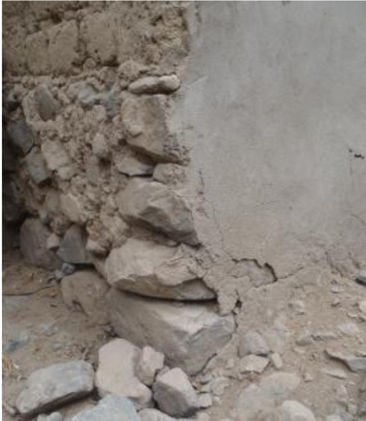
Fig.11 Sobrecimiento tarrajado con mortero de cemento (lateral) y no tarrajado (posterior) de una vivienda en el pueblo de Apan.
