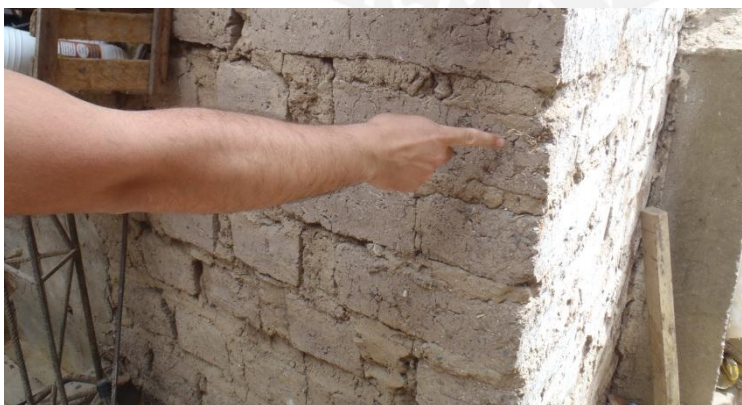
Fig.10 Mortero de pega de 2cm de espesor, se utiliza el mismo material que para los adobes
