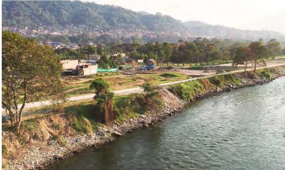
F32. Vista aérea de la zona del proyecto
