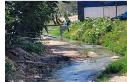
Carencia de servicios de desagüe
