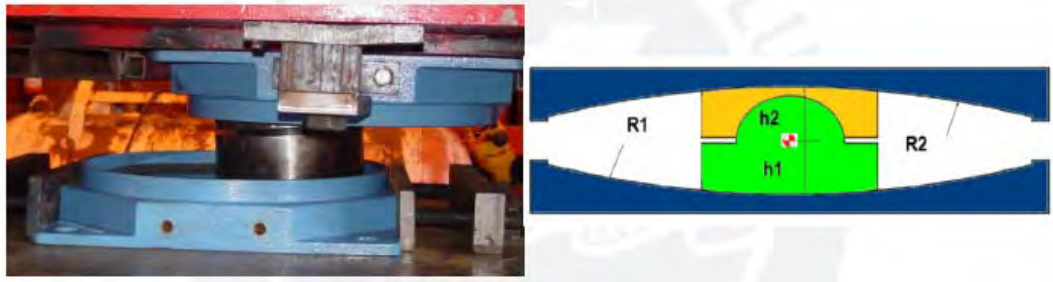
Figura 11: Aislador de Péndulo Doble. (Constantinou, 2004)
