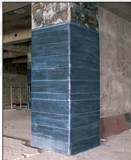
Figura 6: Encamisetado con materiales compuesto. (Sika, 2017)
