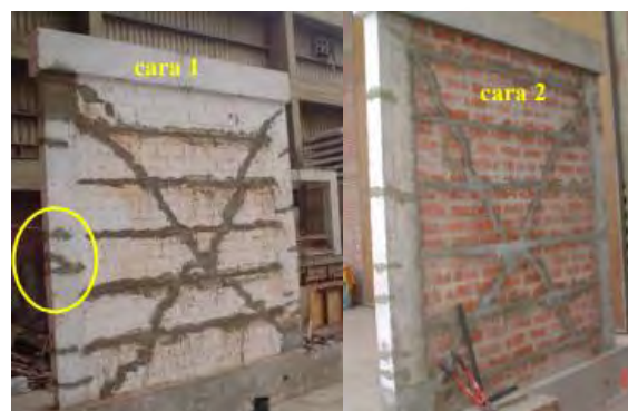
Figura 15. Aplicación de varillas de fibra de vidrio sobre muro (Fuente: San Bartolomé y Loayza)
