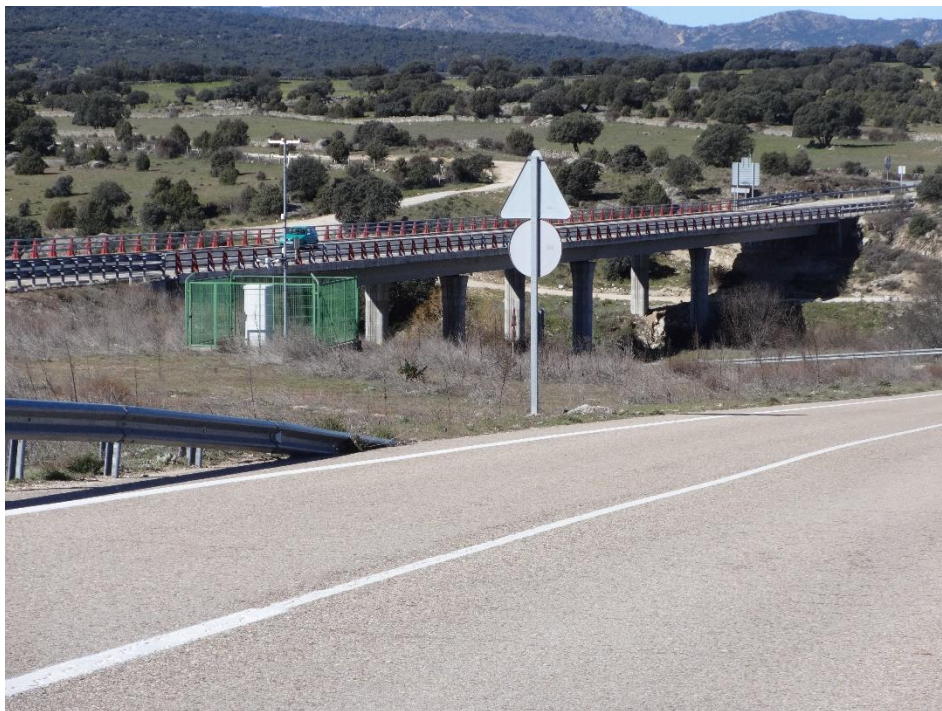
Puente sobre el Río Manzanares
