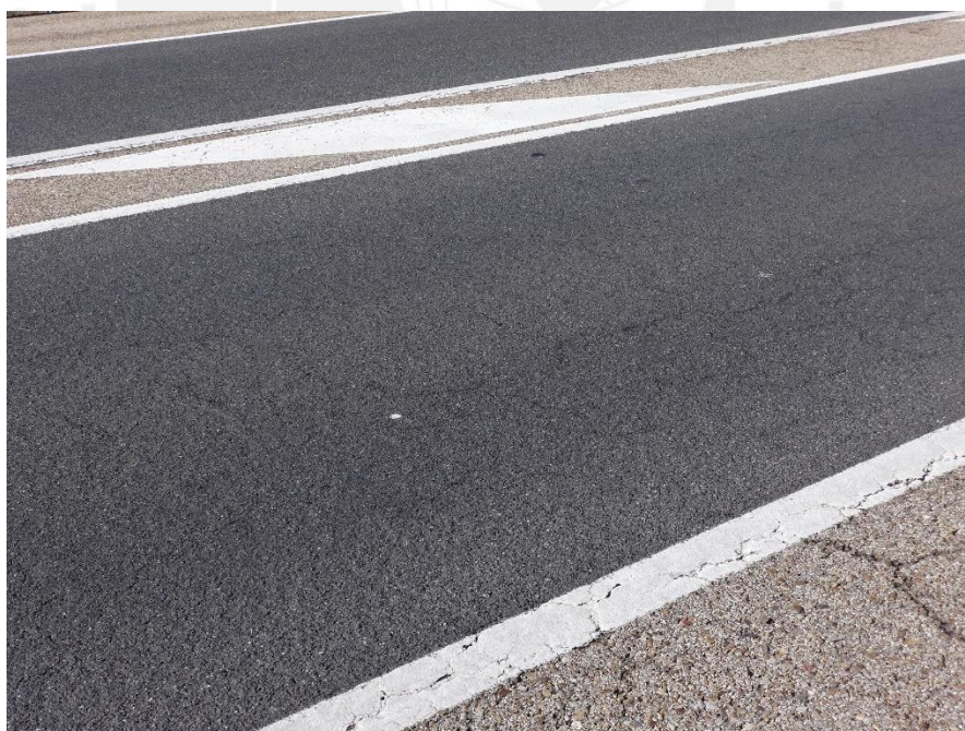
Detalle de pavimento
