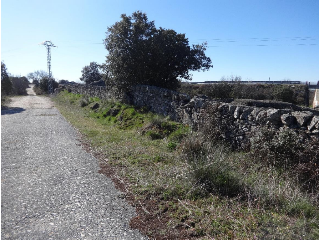
Via pecuaria progresiva 1+780
