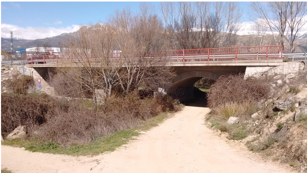
Puente sobre Río Samburiel.
