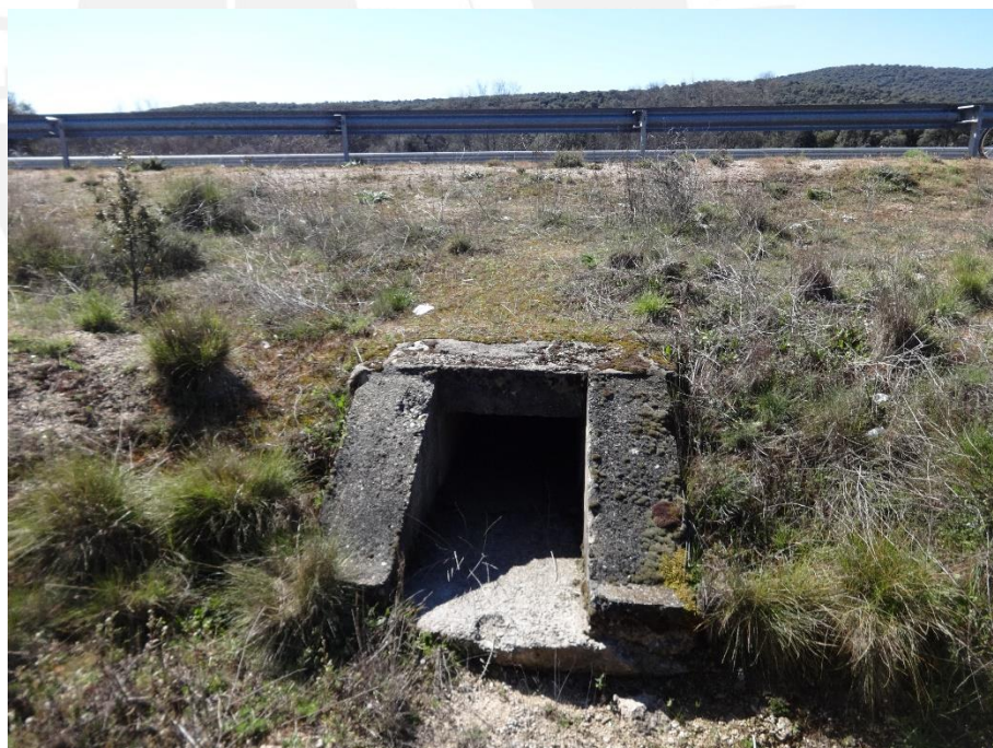
Obra de drenaje transversal
