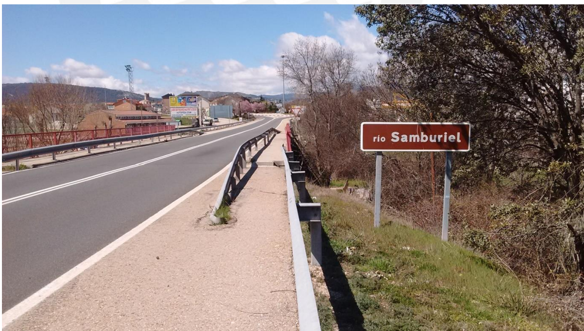
Puente sobre Río Samburriel
