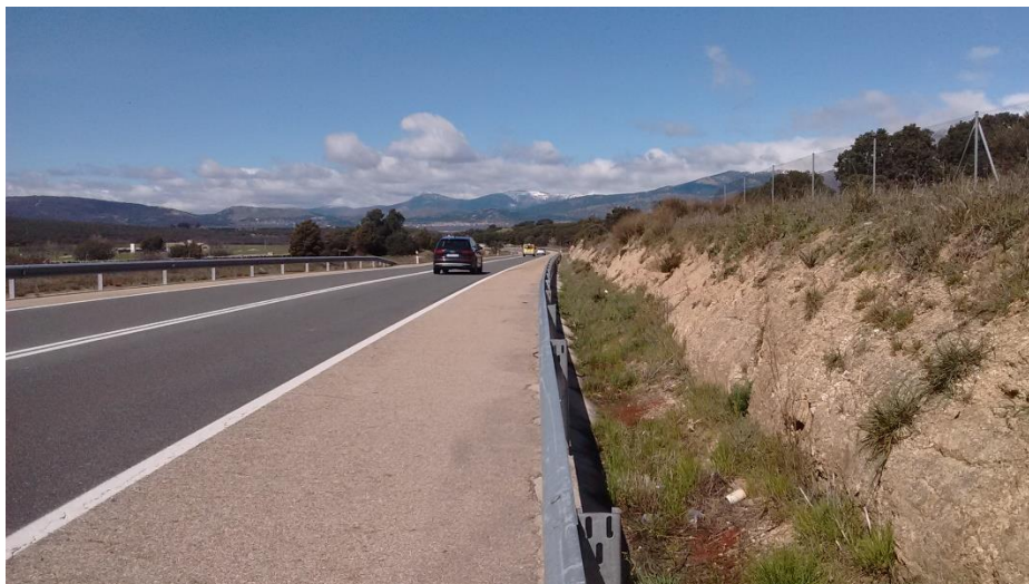
Cuneta con vegetación
