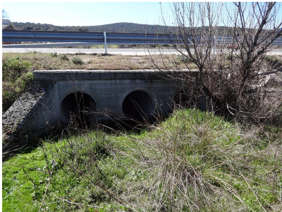
Obra de drenaje transversal
