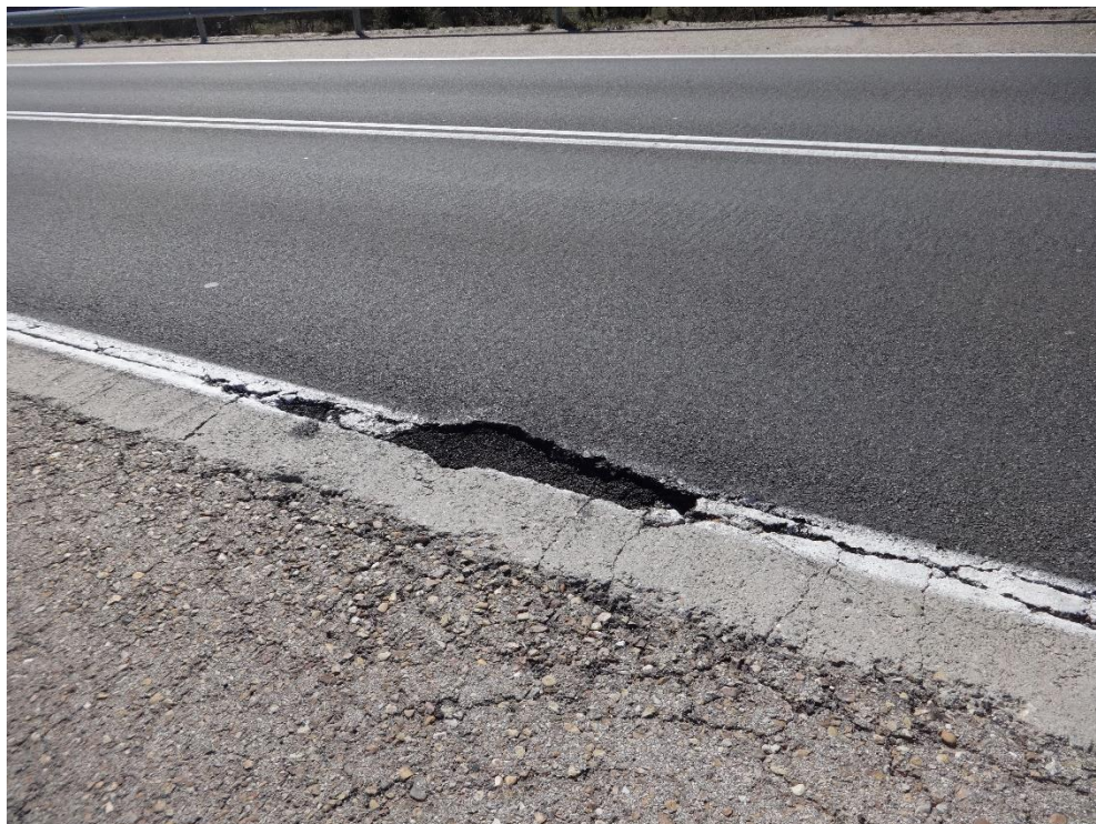
Detalle de pavimento
