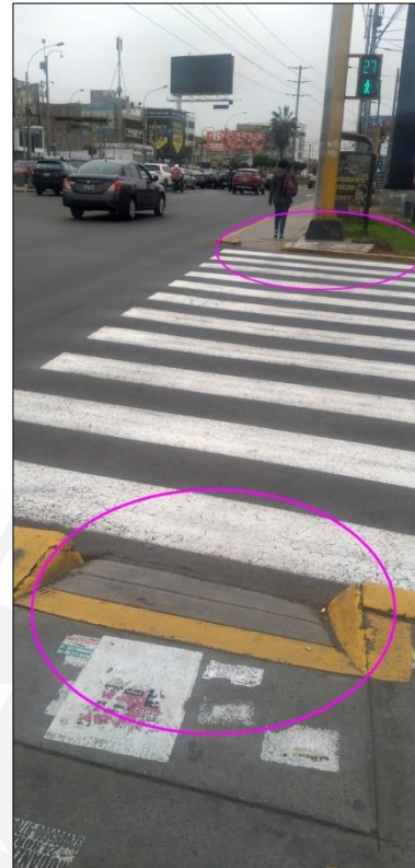
Figura 6. Ancho de rampas peatonales insuficiente.
