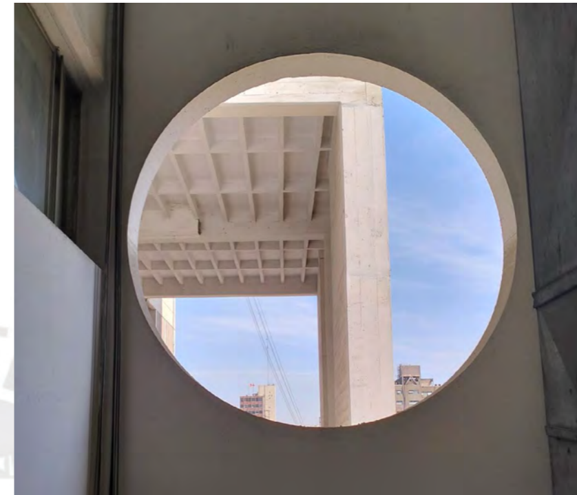
Vista interior - escalera de emergencia
