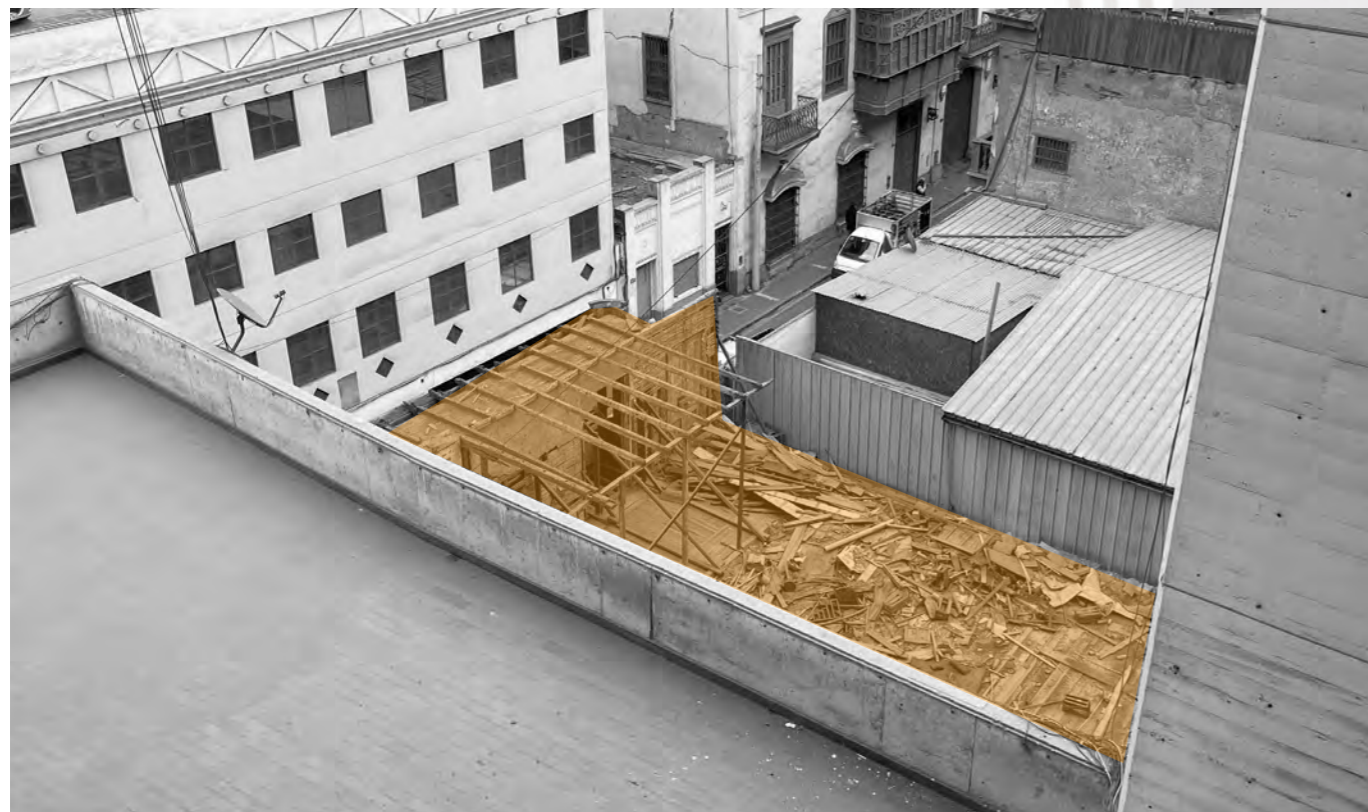
Lote de intervención - vista de techo
