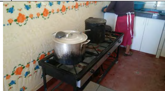
Piso y cocinas en mal estado de higiene
