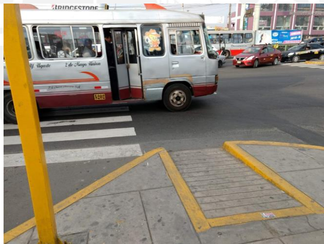
Figura 5.14: Discontinuidad entre rampa y cruceo.
