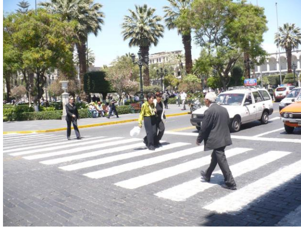
Figura 2.19: Cruce peatonal y barra de parada.
