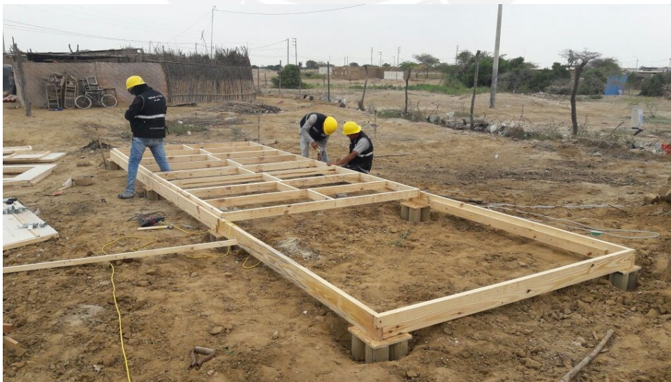
Figura XI: Proceso de instalación de plataformas para piso – modelo 2
