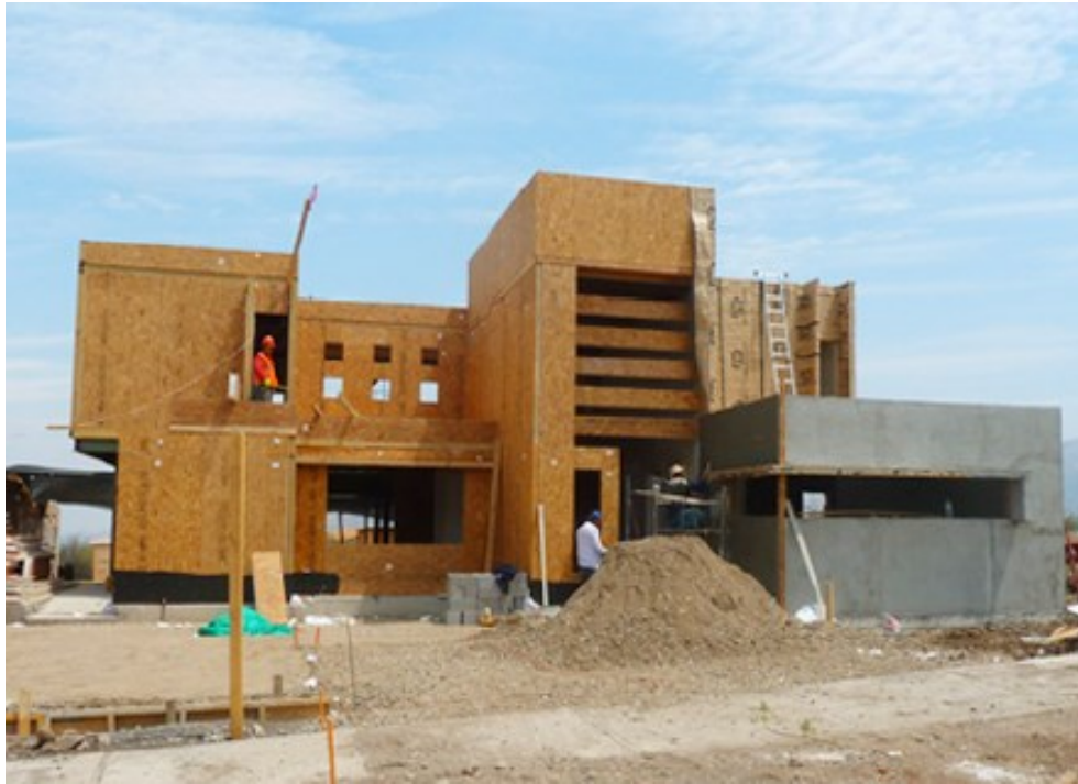
Figura XVI: Estructura de dos pisos construida con paneles SIP
