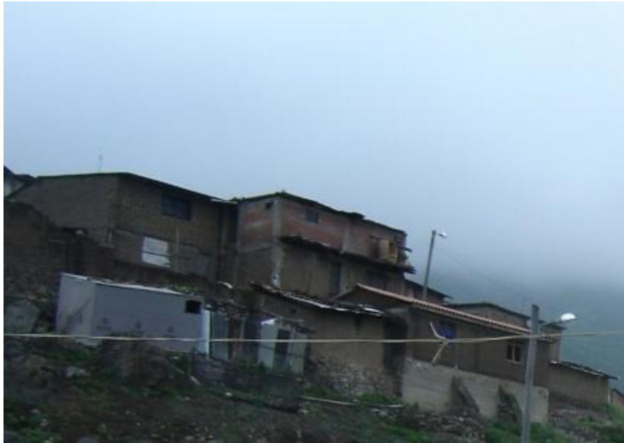
Figura 19: Vivienda con muros de arcilla en segundo nivel y muros de adobe en primer nivel en comunidad rural del Perú
