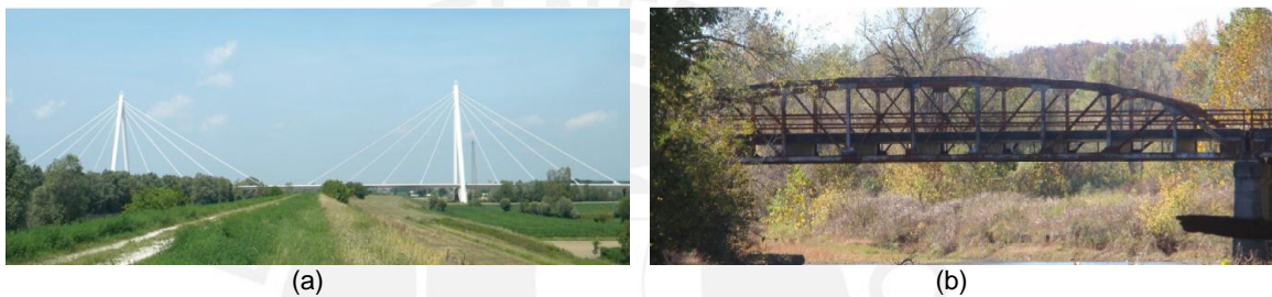
Figura 3.6 (a) Puente atirantado Adige, sureste de Verona, Italia (Argentini et al. 2012), (b) Tramo constante del puente en Arkansas (Fernstrom et al. 2012)
