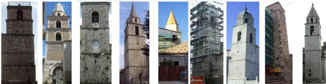
Figura 3.8 Torres de iglesias en las que se realizaron ensayos experimentales (Rainieri y Fabbrocino 2011).
