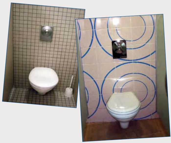
TIPO DE MONTAJE 2: Fijación por delante de pared resistente y recubriendo después por delante con tabiquería ligera u obra de fábrica.
