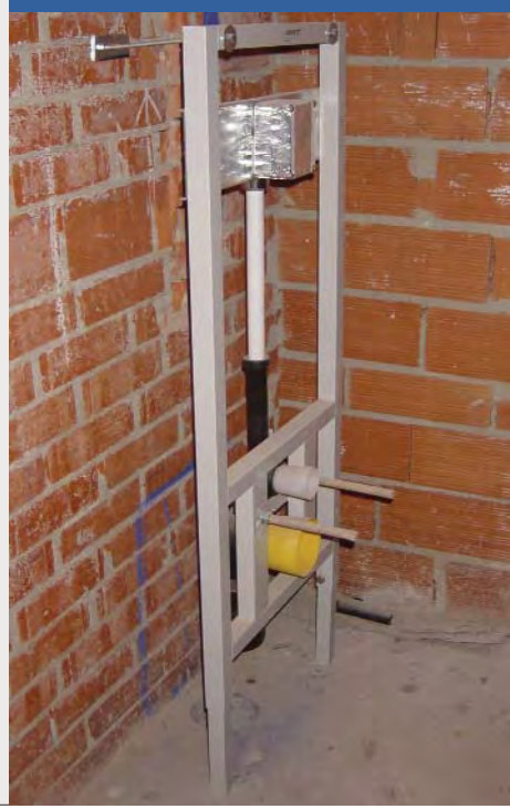
TIPO DE MONTAJE 2: Fijación por delante de pared resistente y recubriendo después por delante con tabiquería ligera u obra de fábrica.
