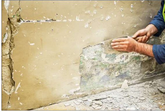
Figura 6.1 Remoción de acabados del muro a reforzar (Quatatis, 2017)
