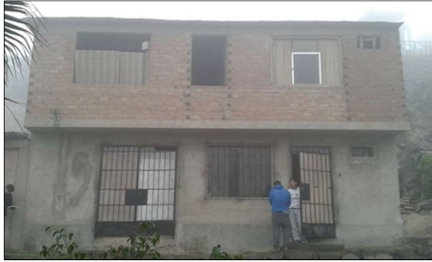
Figura 4.15 Fachada de la vivienda 2 (SENCICO, 2015)
