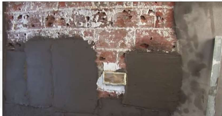
Figura 6.4 Pañeteo de muro reparado (Google, 2014)
