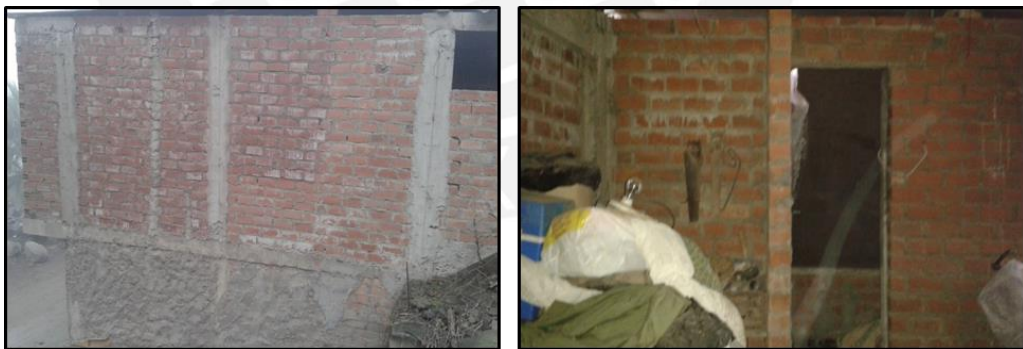
Imagen 1.3 Muros de ladrillo King Kong
