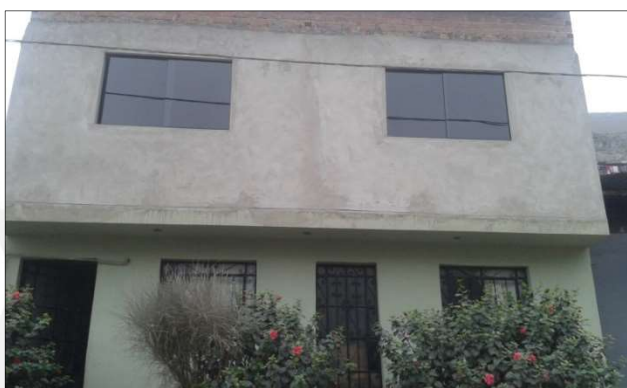
Figura 4.12 Fachada de la vivienda 1 (SENCICO, 2015)
