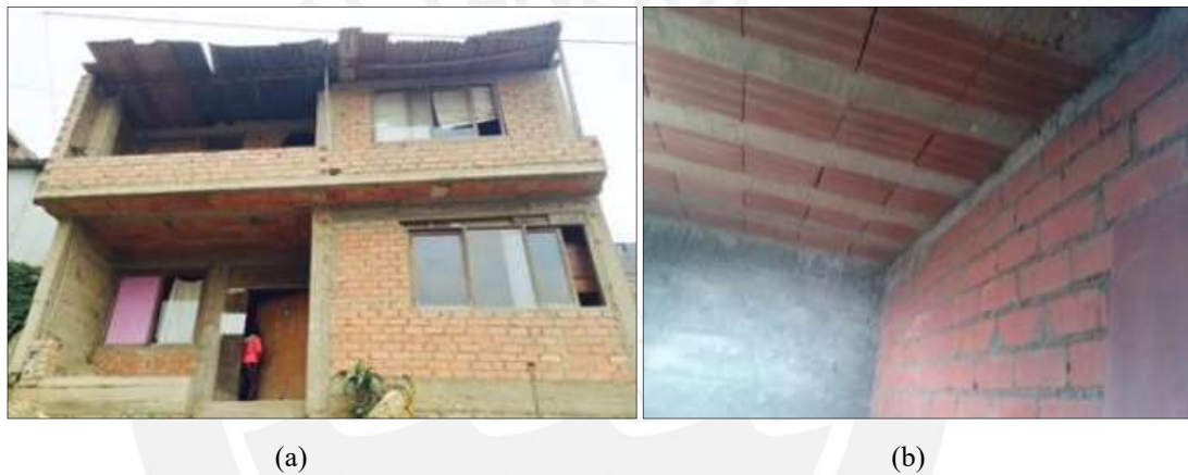
Figura 4.11 Viviendas con ladrillo de arcilla (a) en muros exteriores y (b) en muros interiores (SENCICO, 2015)
