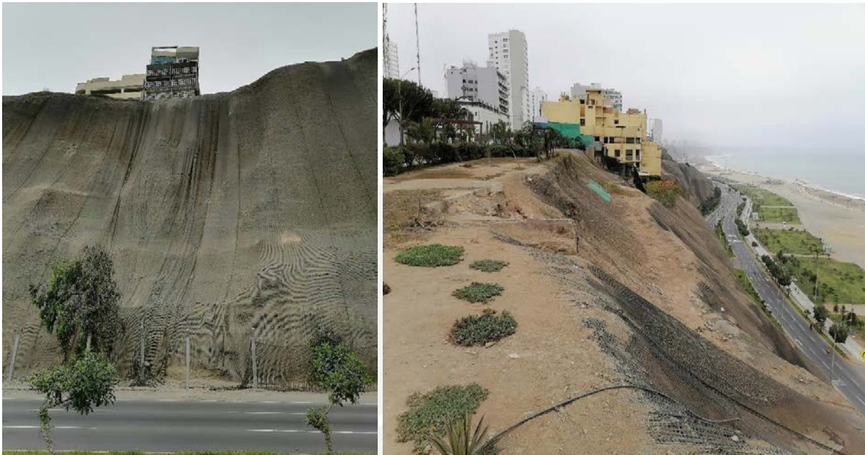
Fotografía 1 Edificaciones construidas en la corona de laderas – Costa verde Lima.
