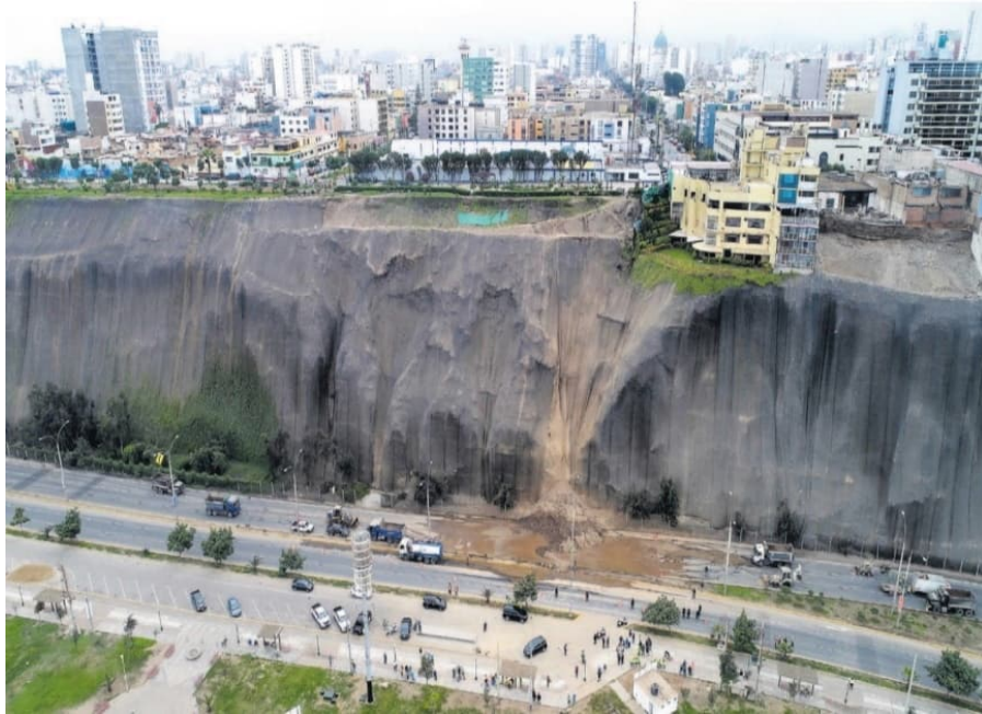
Fotografía 2 Vista frontal del acantilado de interés 08-08-2019 (Fuente El comercio).
