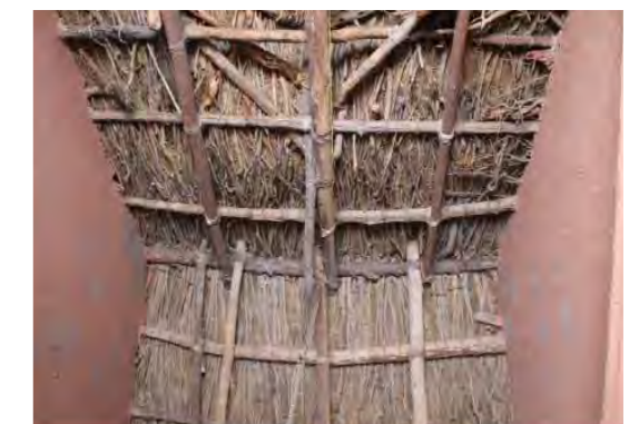
F. 17. Detalle cubierta Fotografía: Atlas (2019)
