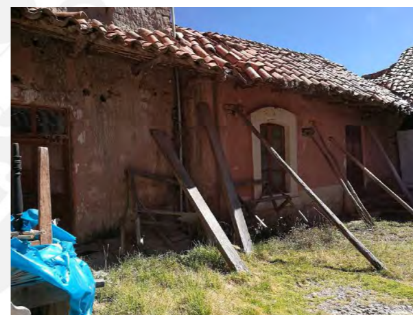
F. 21. Interior de casona Fotografía propia (2019)
