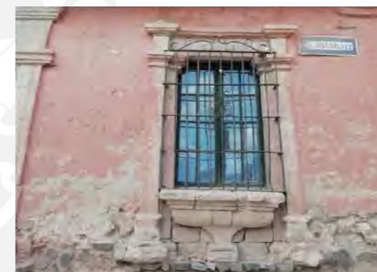
F. 16. Sobrecimiento Fotografía propia (2019)
