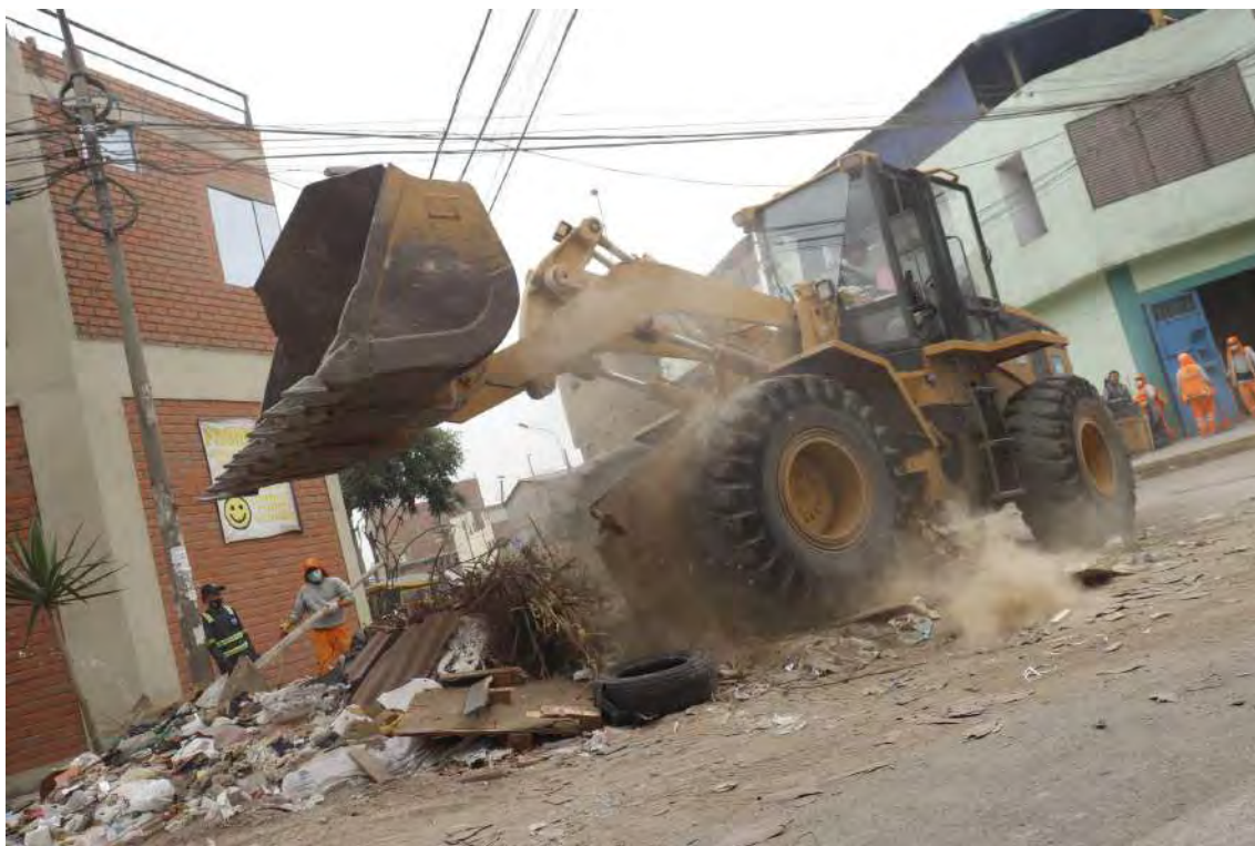
Figura 161. Maquinaria de derrumbe/desmonte.
