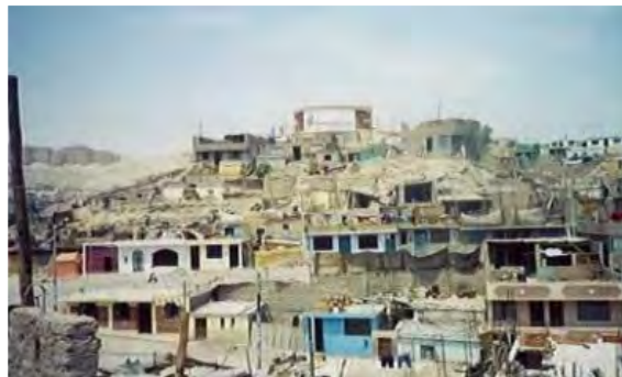
FIGURA 1- 3 VIVIENDAS DE ALBAÑILERÍA AUTOCONSTRUÍDA INFORMALMENTE (FUENTE: SANTISTEBAN, 2005)
