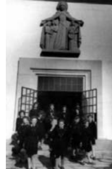
Figura 20. Fachada del Colegio Santa Úrsula (1941). Fuente: Archivo de Arquitectura PUCP.
