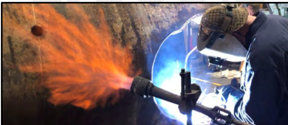
Figura 12. Precalentamiento en tubería. Nota. Tomado de “Weldinganswers”, 2023.
