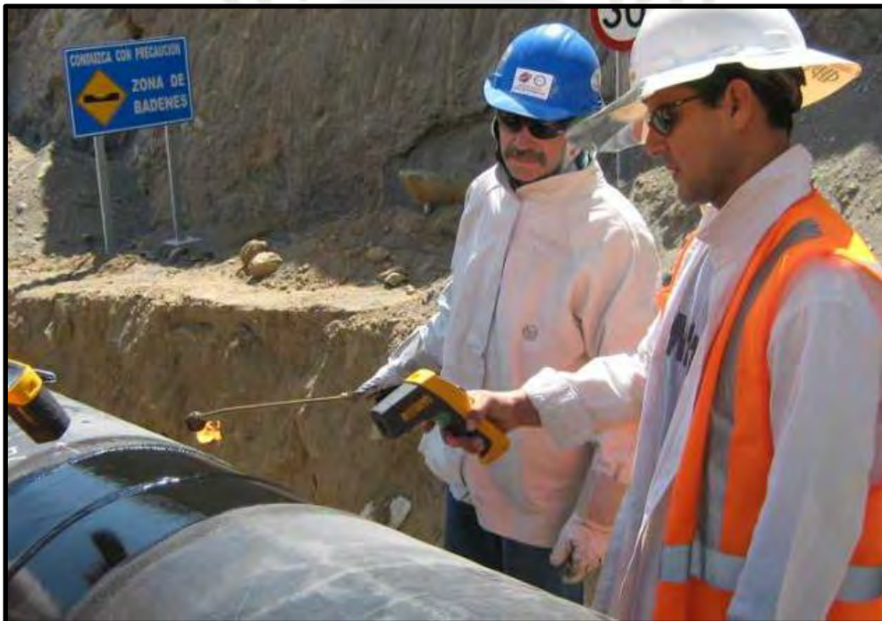
Figura 24. Inspección visual Nota. Tomado de “GAMAIN”, 2017.
