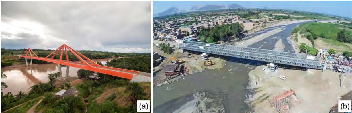
Figura 15. Puentes en armadura en el Perú
