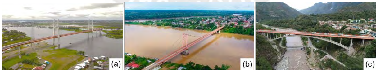
Figura 11. Puentes viales del Perú.
