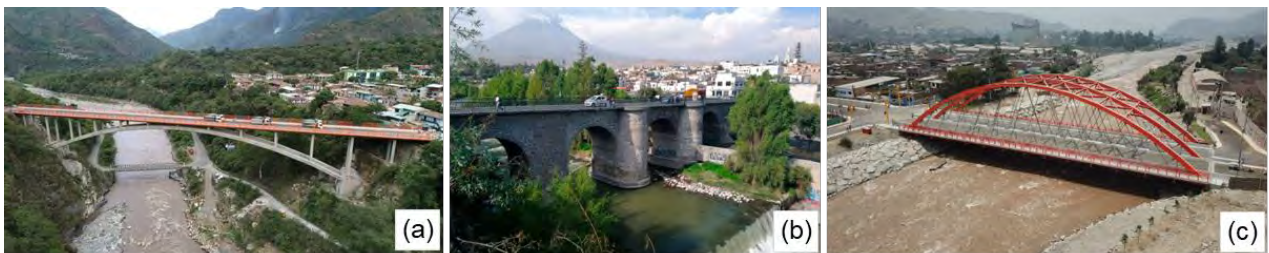
Figura 16. Puentes en arco en el Perú
