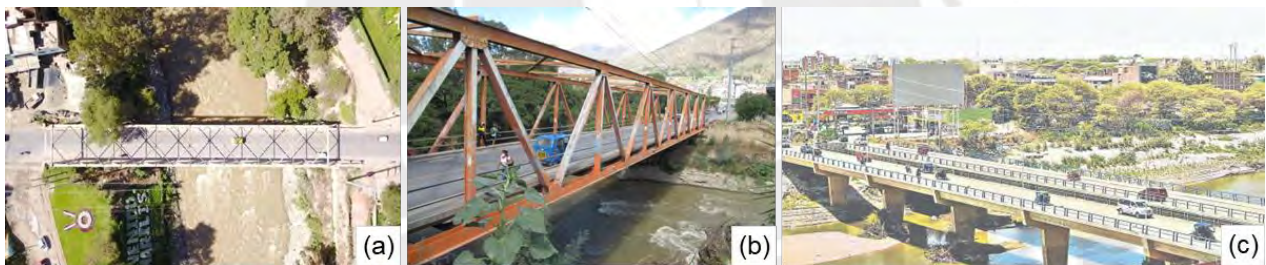
Figura 27. Puentes monitoreados en el Perú.
