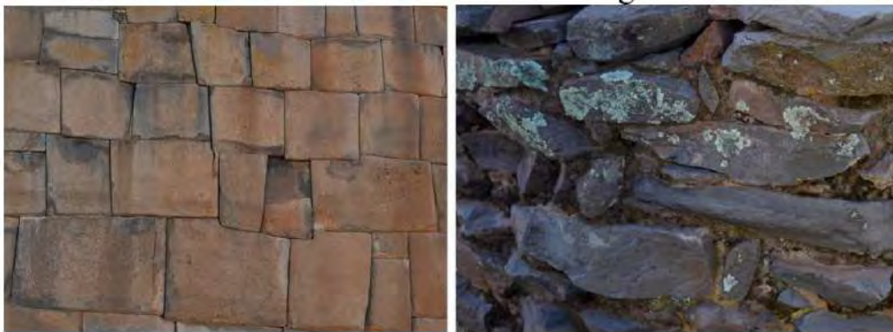
Figura 3-21: Cutimbo (a) Tipología 1 (b) Tipología 2
