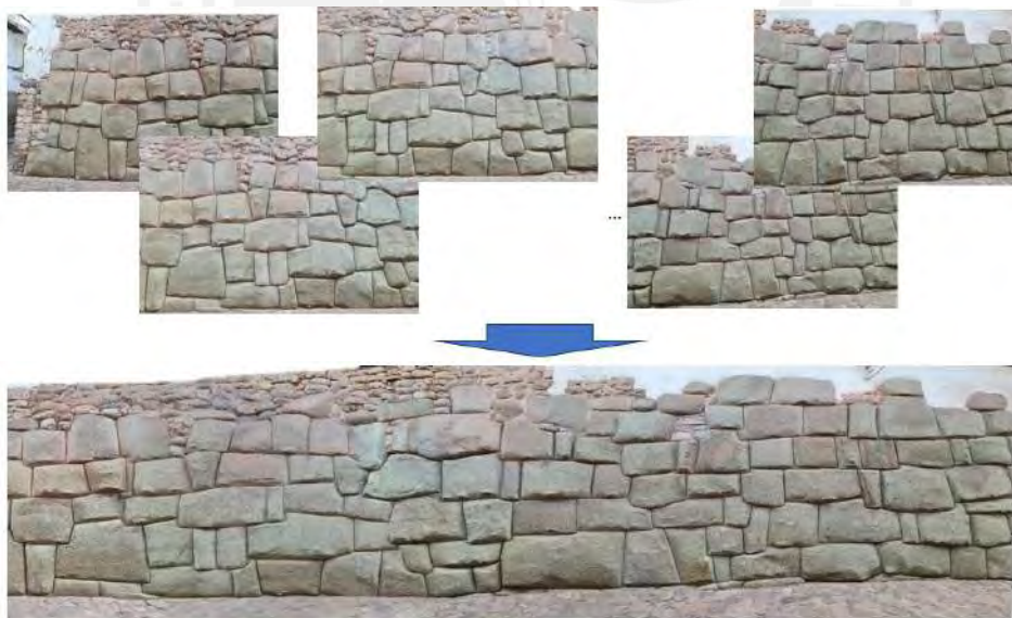
Figura 3-13: Alineación 3D de 7 imágenes tomadas al muro del Templo Arzobispal, Cusco
