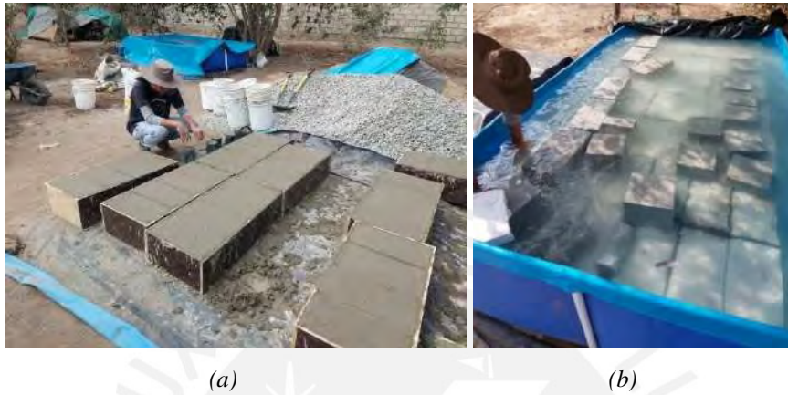
Figura 7-9: Elaboración de bloques de concreto (a) Colocado de concreto (b) Curado de concreto
