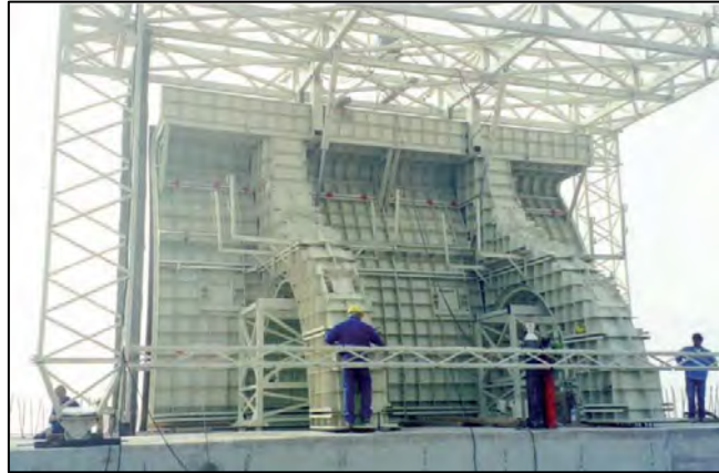
Figura 37 Encofrado de espaldón de hormigón armado.
