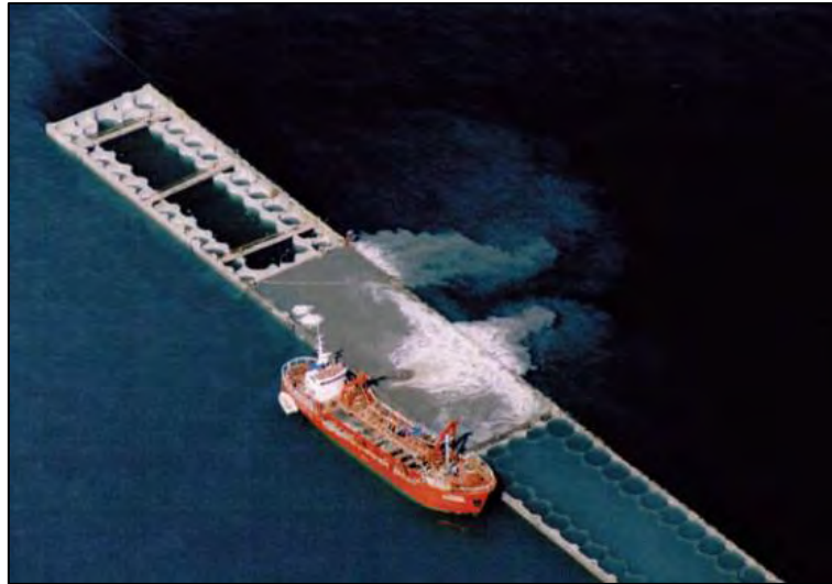
Figura 34 Relleno procedente de dragado.
