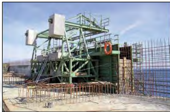
Figura 38 Encofrado viga cantil.
