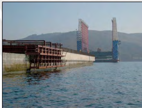
Figura 39 Encofrado viga cantil.
