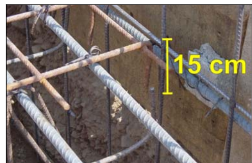
Foto 2.3.13: Anclaje de Malla
