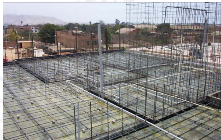
Foto 2.3.57: Vista Panorámica de la Losa de Techo
