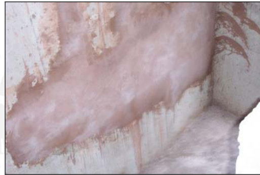
Foto 2.4.18: Muros luego del resane correspondiente
