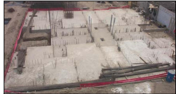
Foto 2: Platea de Cimentación
