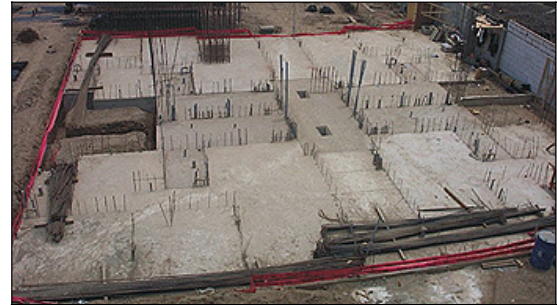
Foto 2: Platea de Cimentación
