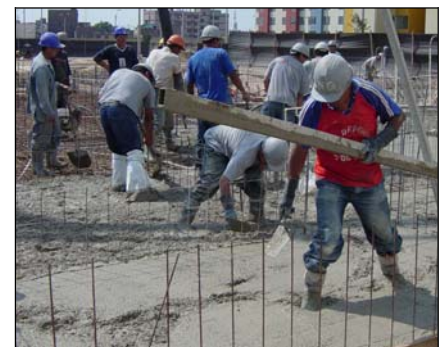
Foto 2.4.7: Vaciado de Cimentación
