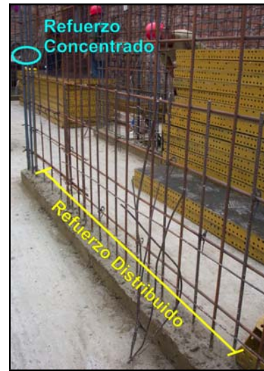
Foto 2.3.22: Refuerzo Distribuido y Concentrado en Muros
