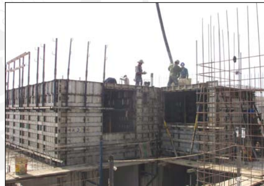
Foto 2.4.15: Vaciado conjunto de muros y losa
