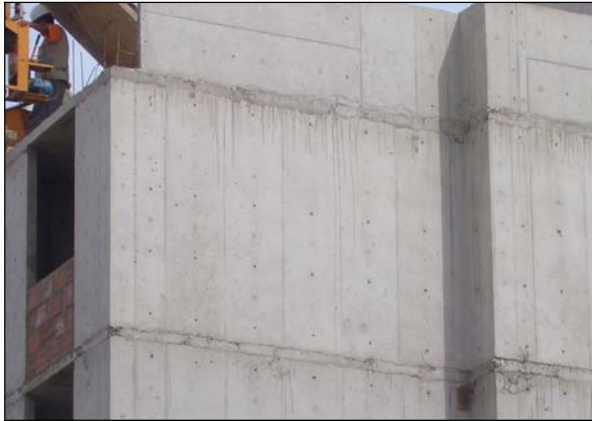
Foto 2.4.25: Juntas Frías en Unión de Muro con Losa
