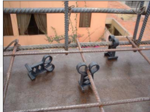
Foto 2.3.61: Empleo de Malla Electrosoldada como Refuerzo de Losa
