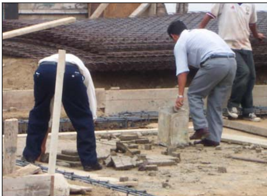
Foto 2.3.15: Fabricación de dados de concreto.
