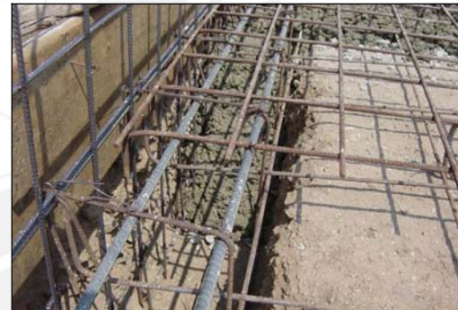
Foto 2.4.6: Espigas ancladas al diente de cimentación
