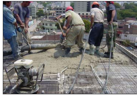
Foto 2.4.16: Vaciado separado de muros y losa
