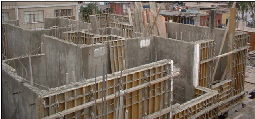
Foto 2.3.50: Vaciado Muro y Losa por Separado
