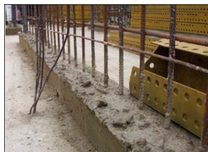
Foto 2.4.12: Muretes de concreto para encofrados
