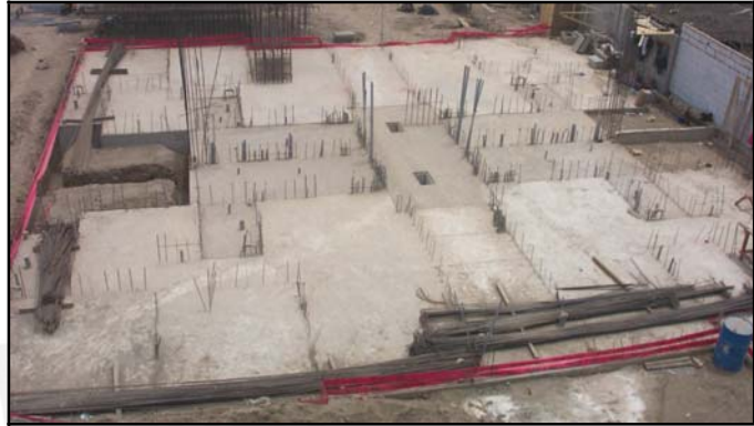
Foto 2.3.10: Platea de Cimentación
