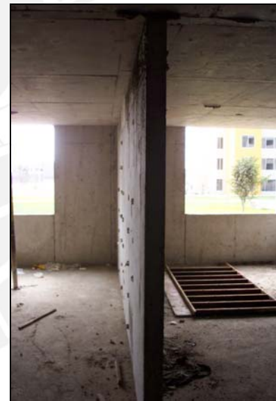
Foto 1: Vista de Muro
