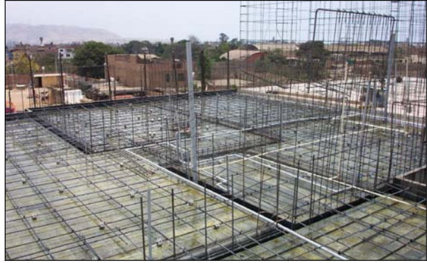
Foto 4: Vista de Losa de Techo
