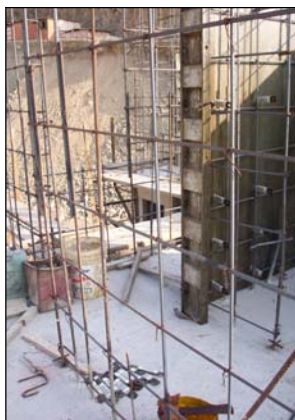
Foto 2.3.23: Uso de Acero Corrugado como Refuerzo de los Muros
