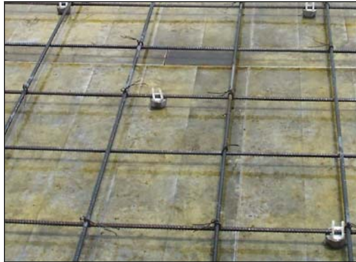
Foto 2.3.60: Empleo de Acero Corrugado como Refuerzo de Losa
