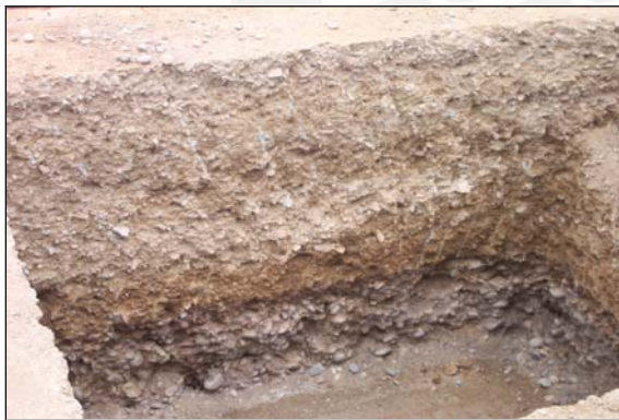
Foto 2.4.1: Capas del Relleno Compactado
