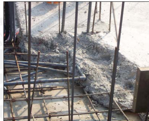
Foto 2.4.27: Junta de Losa
