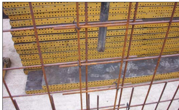
Foto 2.3.24: Uso de Malla Electrosoldada como Refuerzo de los Muros
