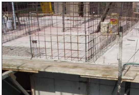
Foto 2.3.58: Detalle de Losa Maciza
