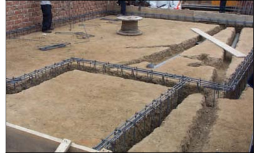
Foto 2.4.4: Colocación del refuerzo de los dientes de cimentación
