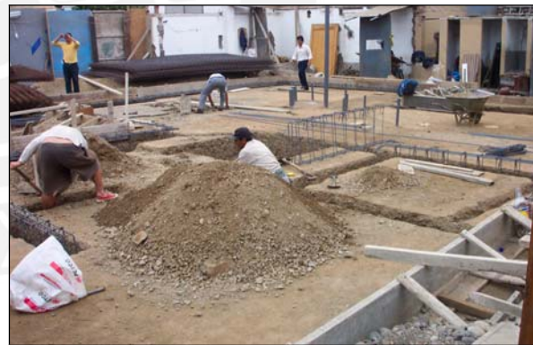
Foto 2.4.2: Excavación de los dientes de la Platea de Cimentación
