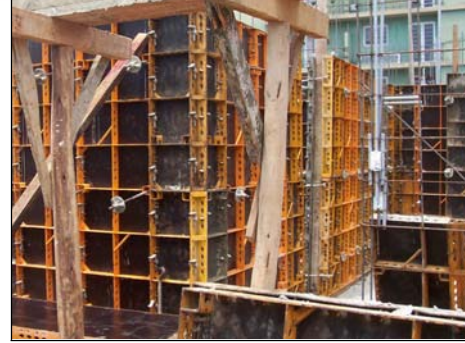
Foto 2.4.10: Encofrados de Madera Prensada
