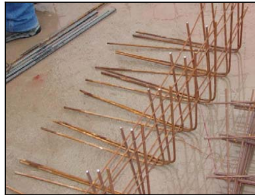
Fotos 2.3.29: Elementos Prefabricados para Esquinas de Muros con Malla Electrosoldada
