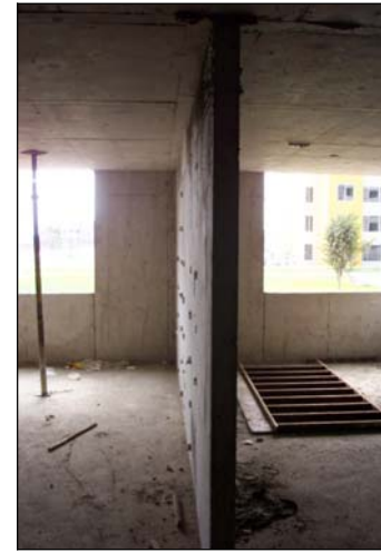
Foto 2.3.1: Vista de Muro Típico
