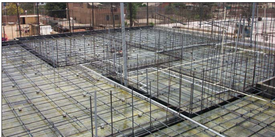
Foto 2.4.19: Encofrado Metálico de Losa
