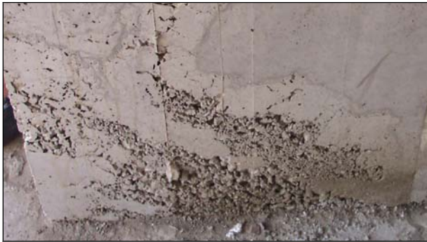
Foto 2.4.17: Imperfecciones previas al resane
