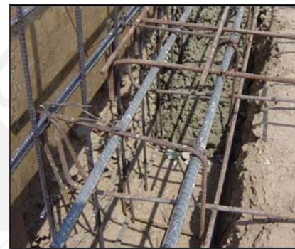
Foto 3.1.2: Anclajes Rectos en la Cimentación
