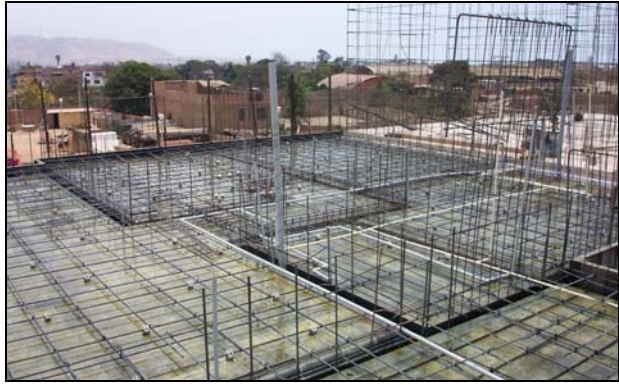
Foto 4: Vista de Losa de Techo
