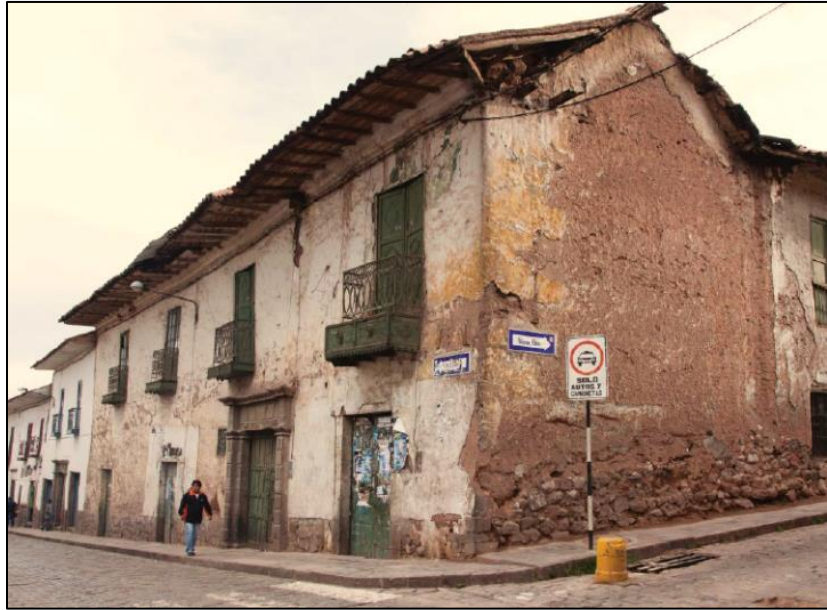
Figura 2.2. Imagen de la Cimentación y Sobrecimiento de la Casa Arones
