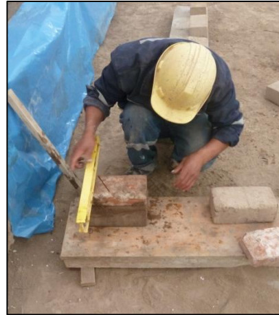
Figura 3.35. Verificación del nivel
