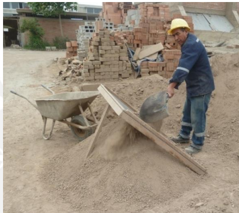
Figura 3.30. Zarandeo del suelo
