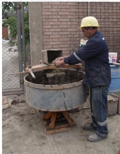
Figura 3.31. Preparación de Mortero
