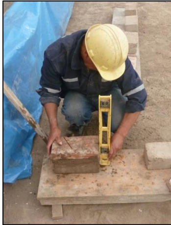
Figura 3.34. Verificación de la plomada
