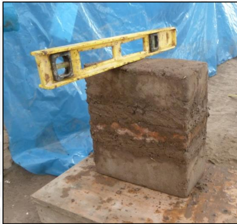
Figura 3.36. Verificación del nivel
