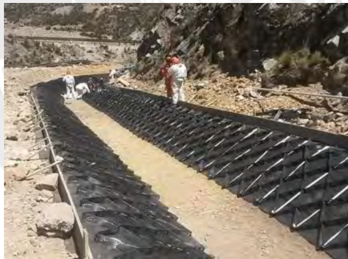
Figura 2.4: Colocación de geocelda texturada y perforada de HDPE (Crispín, 2016).
