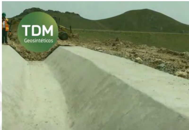
Figura 2.29. Superficie lista para el tendido de geoceldas (TDM, 2019).
