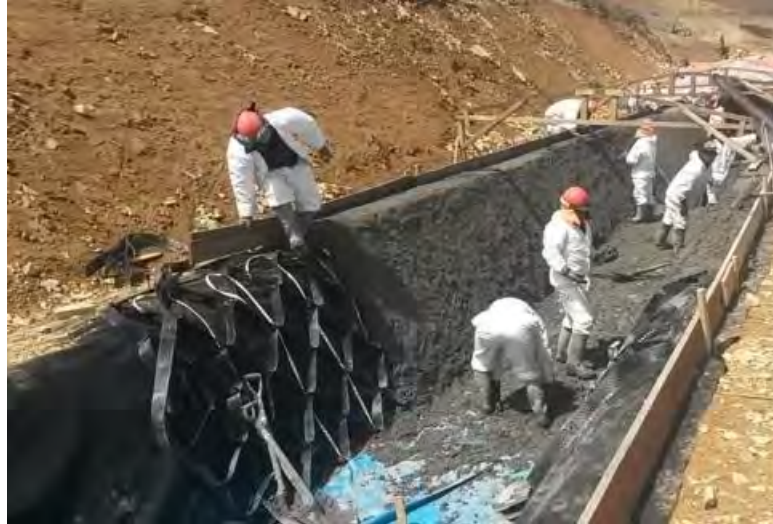
Figura 2.5: Vaciado de concreto en geoceldas (Crispín, 2016).
