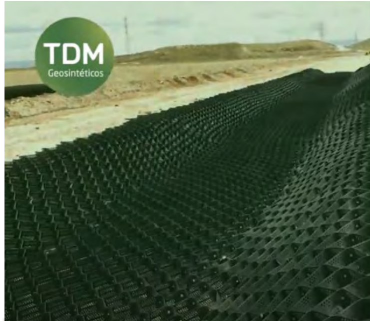
Figura 2.30. Tendido de geoceldas (TDM, 2019).
