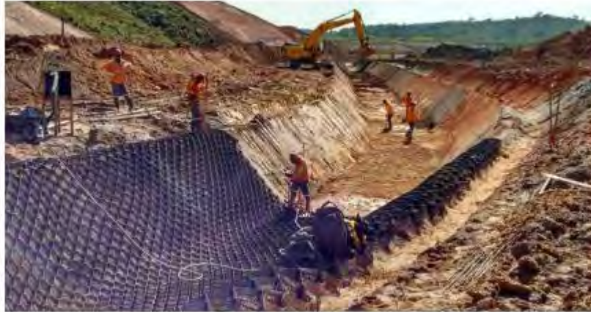
Figura 2.2: Geoceldas HDPE rellenas de concreto en canal minero de Brasil, extensión de 529km (TDM, 2016).
