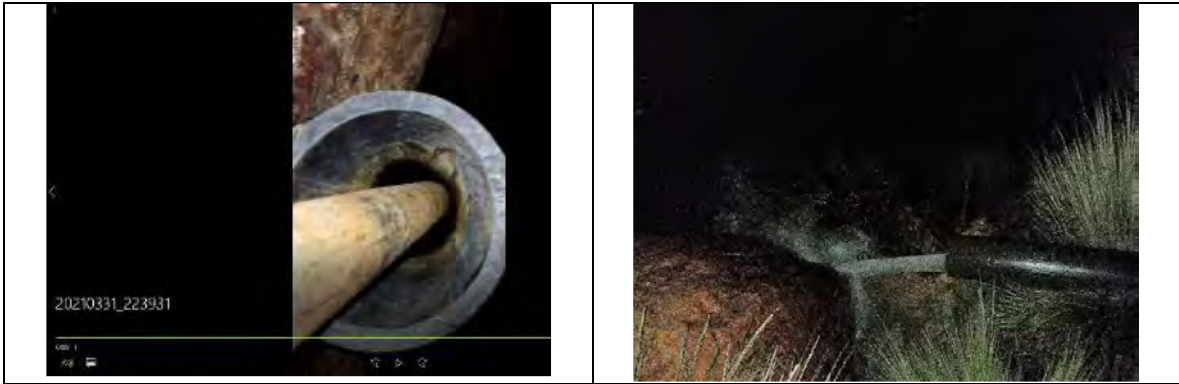
Figura 26 Fotografías de tuberías que descargaban aguas ácidas de la poza de homogenización directamente al río Chacapalca durante la noche
