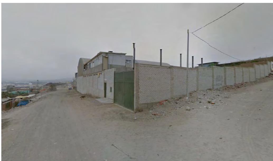
Figura 12. Zona de Acceso de planta Puertas Frigoríficas Latam S.A.C.
